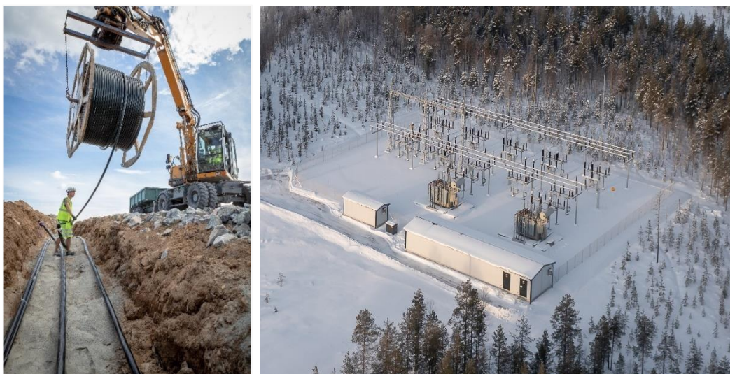
Kuva 3-2. Maakaapelin laskemistyöt (vasemmalla) ja esimerkki tuulivoimahankkeen sähköasemasta (oikealla). © OX2.
