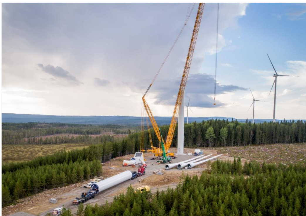
Kuva 3-6 Tuulivoimalan kokoaminen. © OX2 / Joachim Lagercrantz
