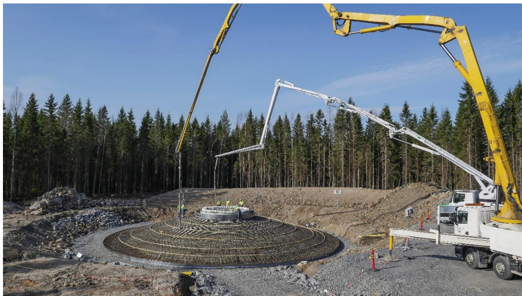
Kuva 3-5. Esimerkki tuulivoimalan perustuksesta. © OX2.
