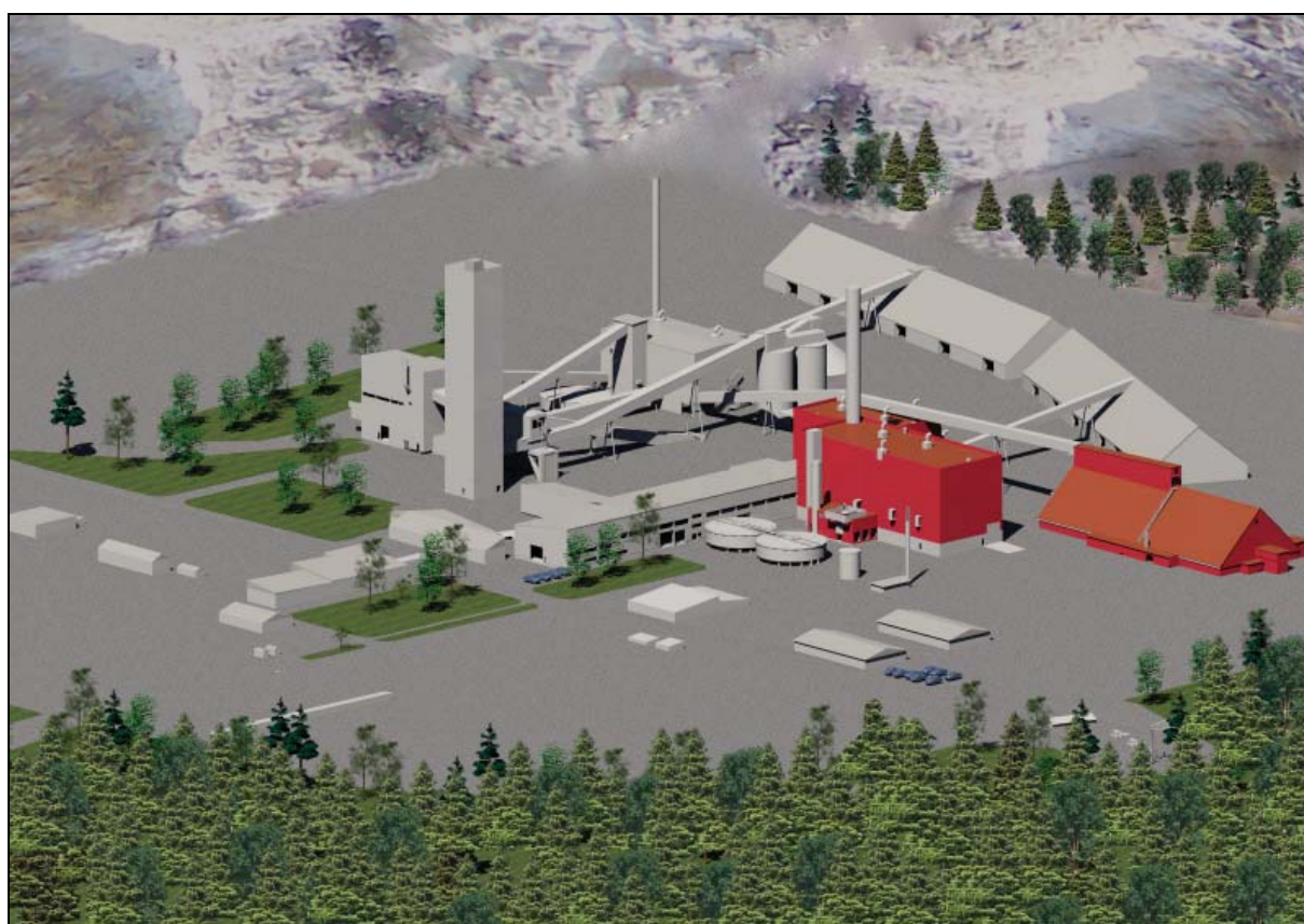
Kuva 5-1. Kemin kaivoksen rikastamo ja laitostilat lounaasta kuvattuna. Uusien rakennusten ja laajennusosien sijainti on esitetty punaisella.
