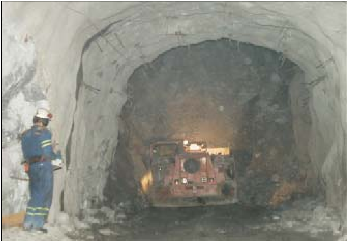
Kuva 4-7. Maanalaisen kaivoksen louhintaa.
