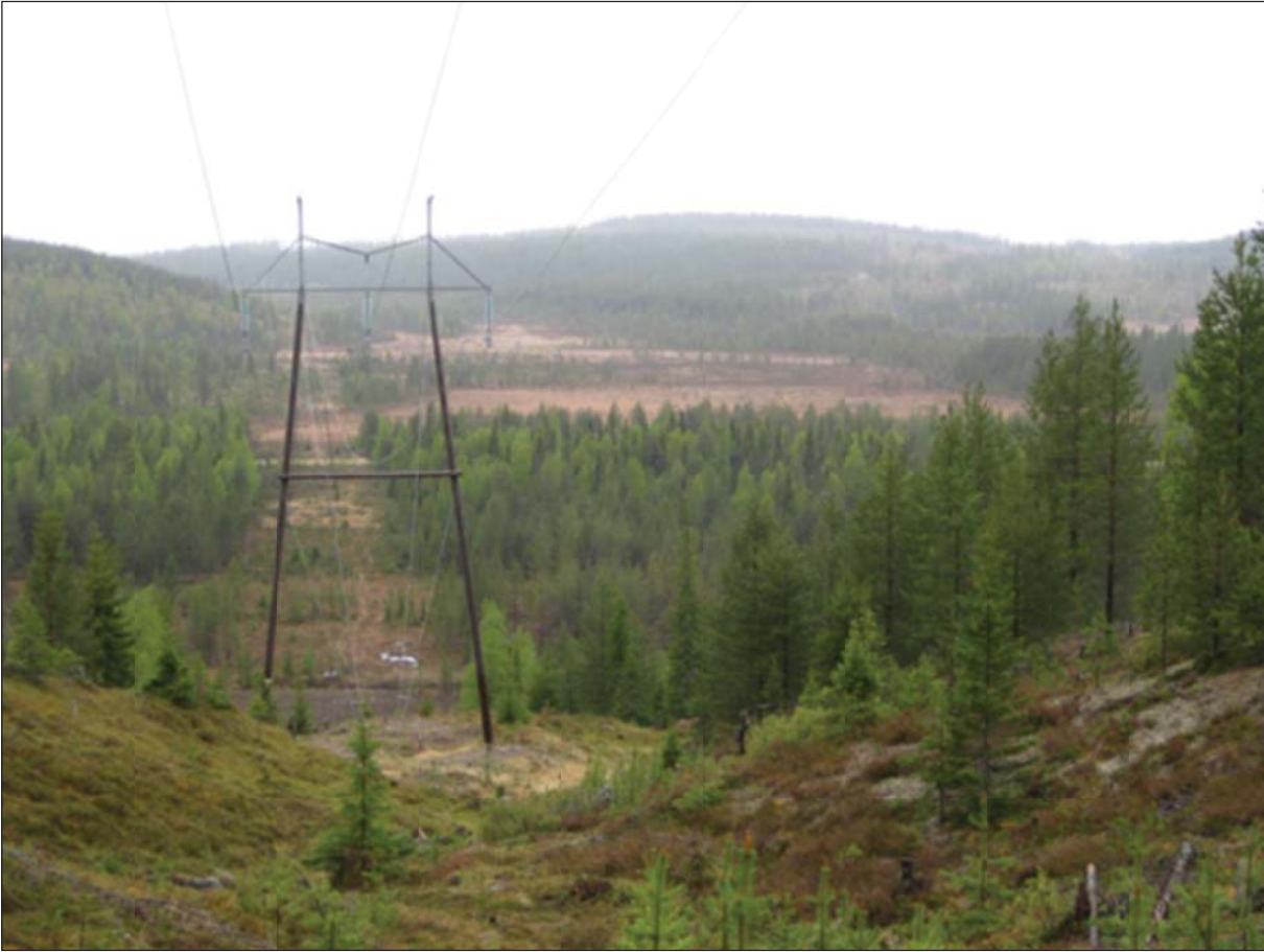
Kuva 35. 110 kV voimajohtolinja Jumisko-Pirttikoski. Näkymä Kuusivaaralta itään. (Kuva Empower Oy/Janne Ruohola 2010)
