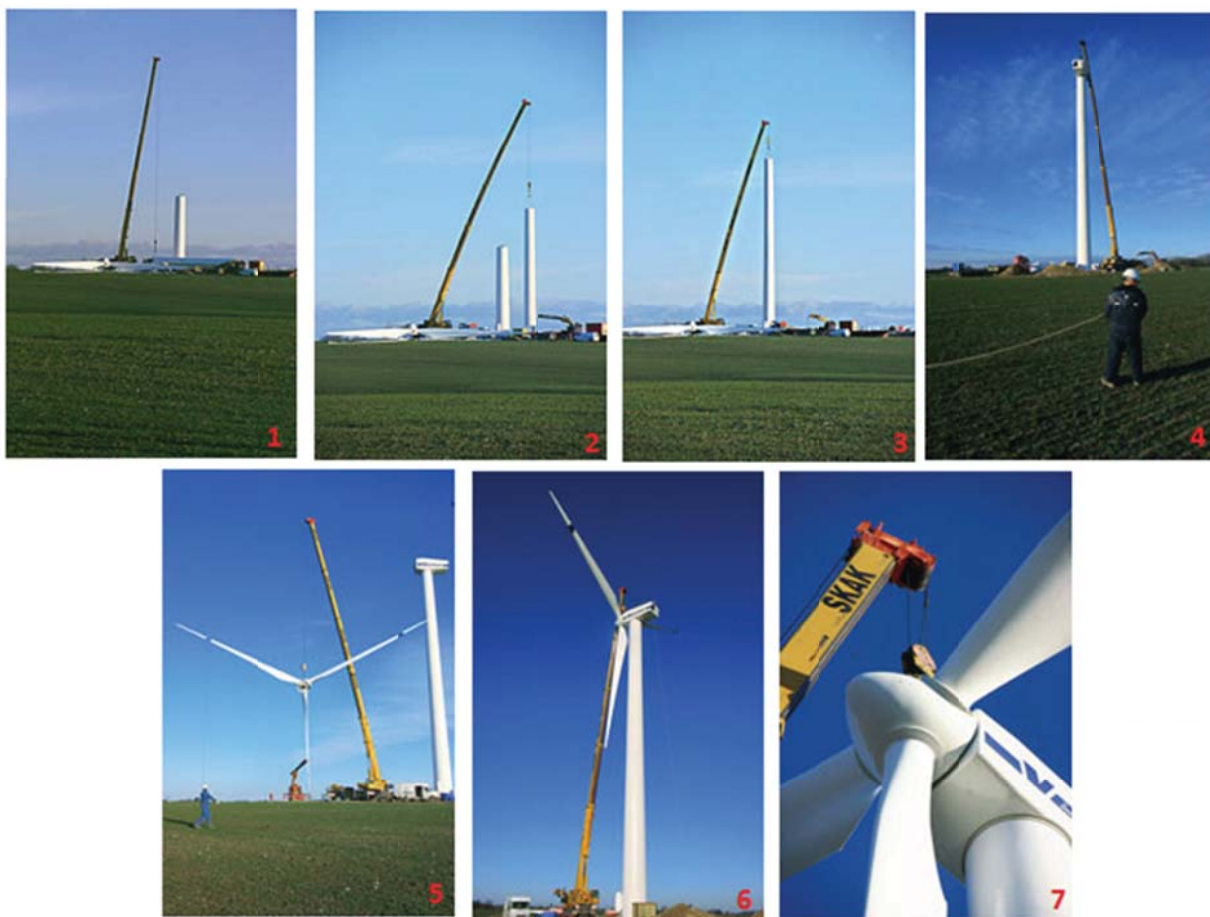
Kuva 24. Kuvasarja tuulivoimalan pystytyksestä: 1) Tuulivoimalan tornin alaosa asennettuna paikoilleen, 2) Tämä 45 metriä korkea torni asennettiin paikoilleen 2 osassa, 3) Jotta kaksi tornin osaa sopisivat tarkasti kohdalleen, täytyy nosturinkuljettajan usein siirtää nosturia millimetreittäin, 4) Konehuonetta asennettaessa pidetään siitä kiinni myös köydellä, 5) Roottorin nosto, noston aikana kaksi miestä pitää lapaa kiinni köysillä, 6) Roottori kiinnitetään konehuoneeseen, kuvassa kaksi miestä maassa auttaa ohjamaan roottorin paikoilleen, 7) Tuulivoimala on valmis kytkettäväksi verkkoon. (www.WINDPOWER.org)
