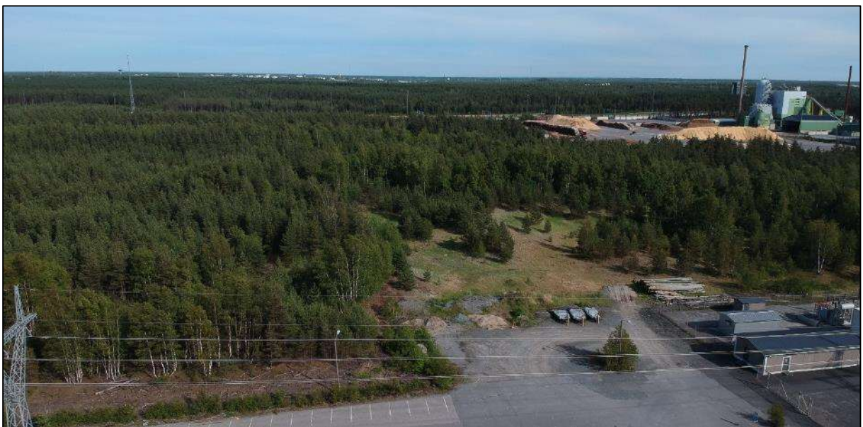
Kuva 78. Viistoilmakuva tehdasalueesta (kuva otettu Kemirantien suunnasta, luoteesta).
