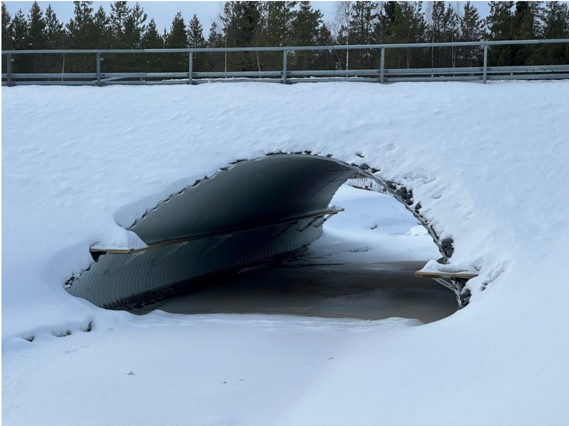
Kuva 13-5. Saukkohyllyt Köyhäjoen ylittävän sillan alla. (Kuva: Jari Venetvaara, Biologitoimisto Jari Venetvaara Ky, maaliskuu 2023)
