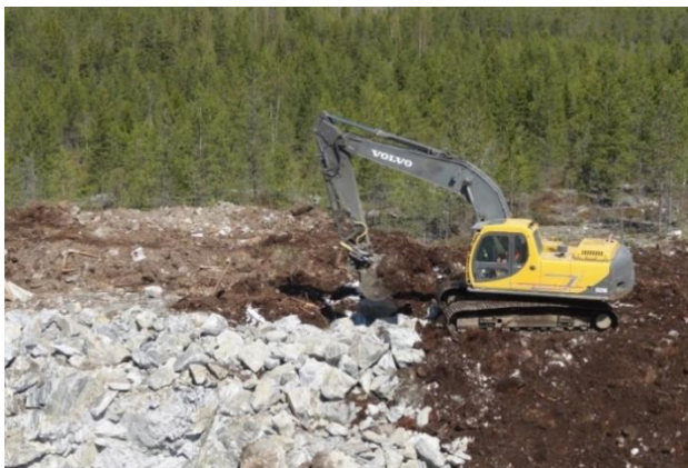
Kuvapari 5.10. Tuulivoimapuiston rakentaminen alkaa huoltoteiden ja pystytysalueiden rakentamisella (Kuvat: Ville Suorsa/FCG).
