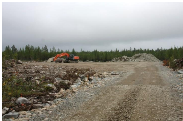
Kuvapari 5.10. Tuulivoimapuiston rakentaminen alkaa huoltoteiden ja pystytysalueiden rakentamisella (Kuvat: Ville Suorsa/FCG).
