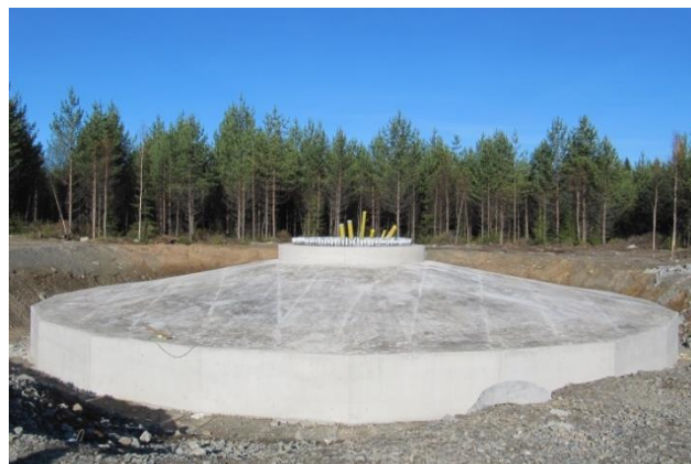
Kuvapari 5.12. Tuulivoimalan perustusten rakentamista (Kuvat: Leila Väyrynen/FCG).
