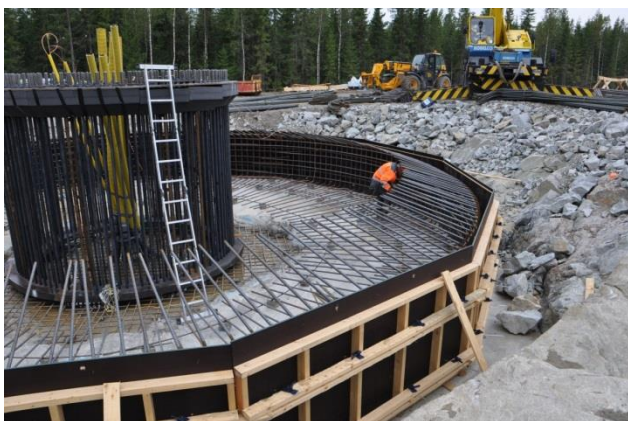
Kuvapari 5.12. Tuulivoimalan perustusten rakentamista (Kuvat: Leila Väyrynen/FCG).
