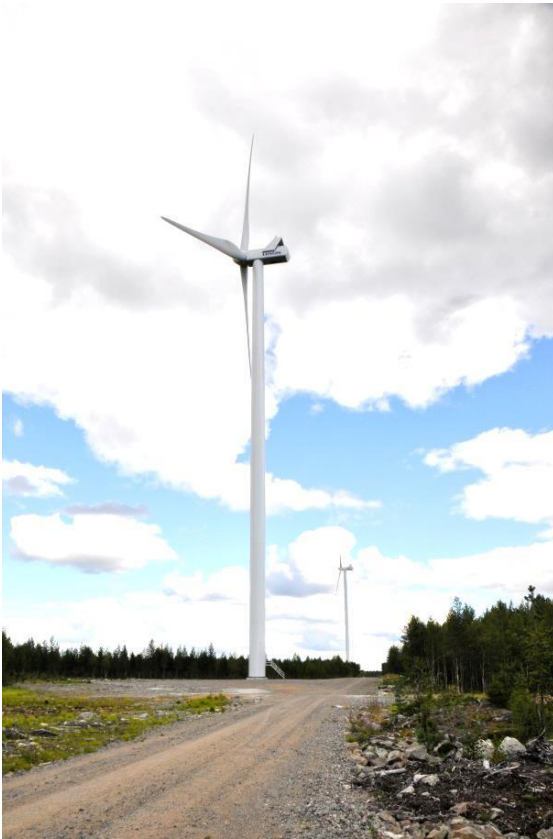
Kuvapari 5.2. Vasemalla on esimerkki teräslieriötornista ja oikealla hybriditornista (Kuvat: Leila Väyrynen ja Ville Suorsa, FCG).
