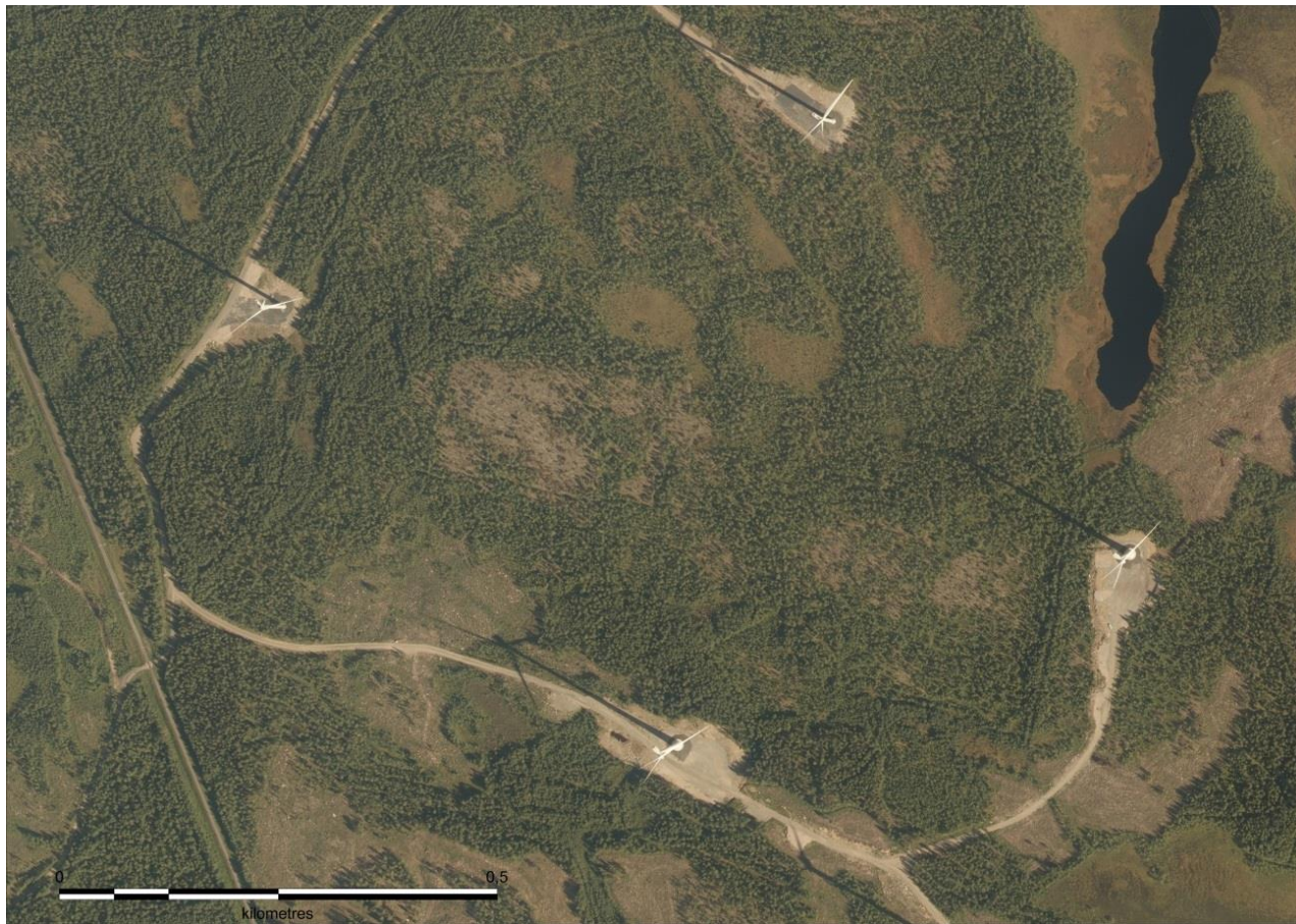
Kuva 5.1. Ilmakuva rakennetusta tuulivoimapuistosta.
