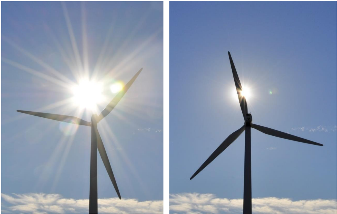
Kuva 17-9. Tuulivoimaloiden lavat aiheuttavat pyöriessään varjon vilkkumista aurinkoisella säällä.
