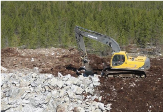
Kuvapari 4-12. Huoltoteiden ja pystytysalueiden rakentamista (kuvat:FCG).
