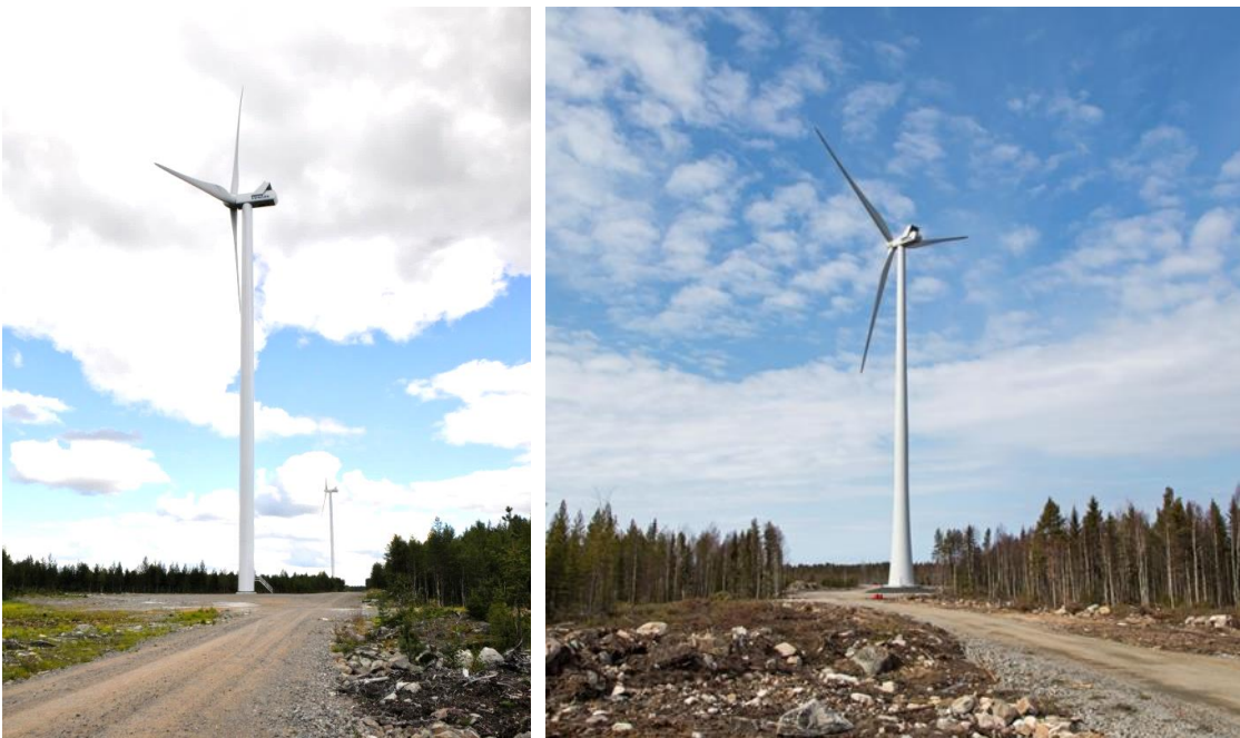
Kuva 4-2. Vasemmalla on esimerkki teräslieriötornista ja oikealla hybriditornista. (Kuvat: Leila Väyrynen ja Ville Suorsa, FCG)
