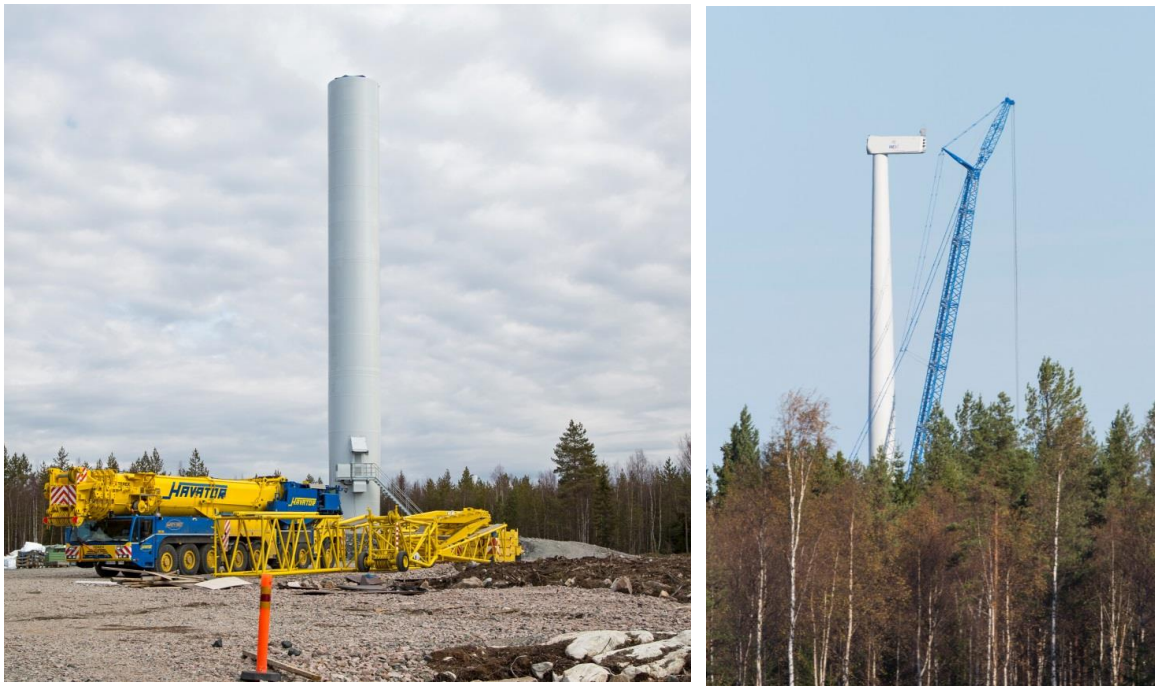
Kuvapari 4-16. Voimaloiden kokoamista (kuvat: FCG).
