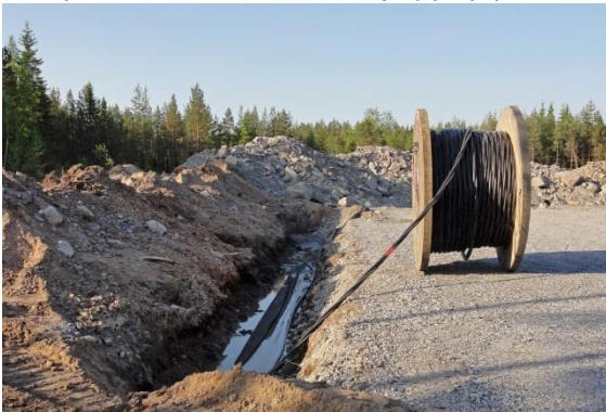
Kuvapari 4-13. Maakaapelit upotetaan huoltoteiden yhteyteen (kuvat: FCG).
