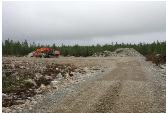
Kuvapari 4-12. Huoltoteiden ja pystytysalueiden rakentamista (kuvat:FCG).
