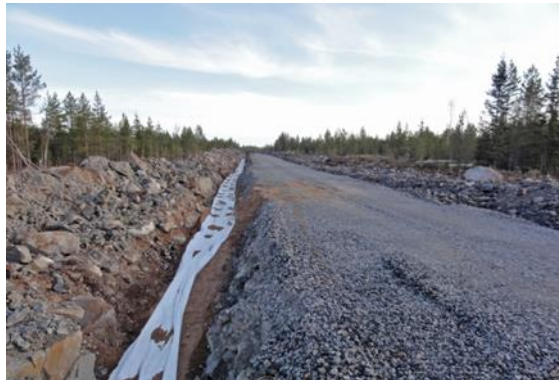
Kuvapari 4-13. Maakaapelit upotetaan huoltoteiden yhteyteen (kuvat: FCG).
