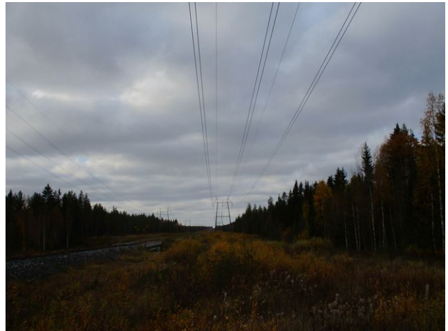
Kuva 25. Rata ja voimalinja hankealueen pohjoisrajalla.
