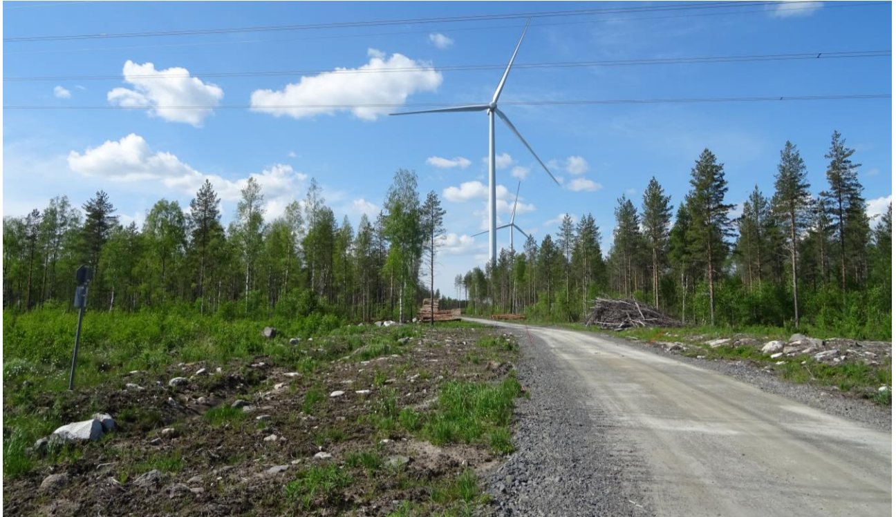
Kuva 16. Esimerkki tuulivoimapuiston rakennus- ja huoltotiestä. Maakaapelin oja on sijoitettu tien vasemmalle puolelle. (Kuva: Sweco Finland Oy)
