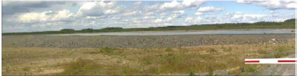
Kuva 127. Nykyinen pato. Kuva otettu Pampalon kaivosalueen portilta silmän korkeudelta. (kuva: Kaija Maunula)
