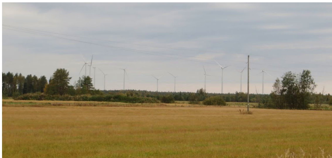
Kuva 47. Tuulivoimaloiden näkyvyyteen maisemassa vaikuttaa vallitsevat sää- ja valo-olosuhteet sekä tarkastelupaikan ja etäisyyden suhde voimaloihin nähden. Kuvassa Pyhäjoen Mäkikankaan tuulipuisto kuvattuna avoimelta peltoalueelta, Mehtäkylän tien varrelta. Etäisyyttä lähimpiin voimaloihin n. 4 km.
