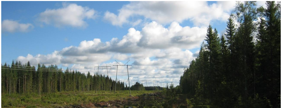
Kuva 42. Olemassa olevaa voimajohtoaukeaa, jonka rinnalle 110 kV voimajohdot liittyvät.
