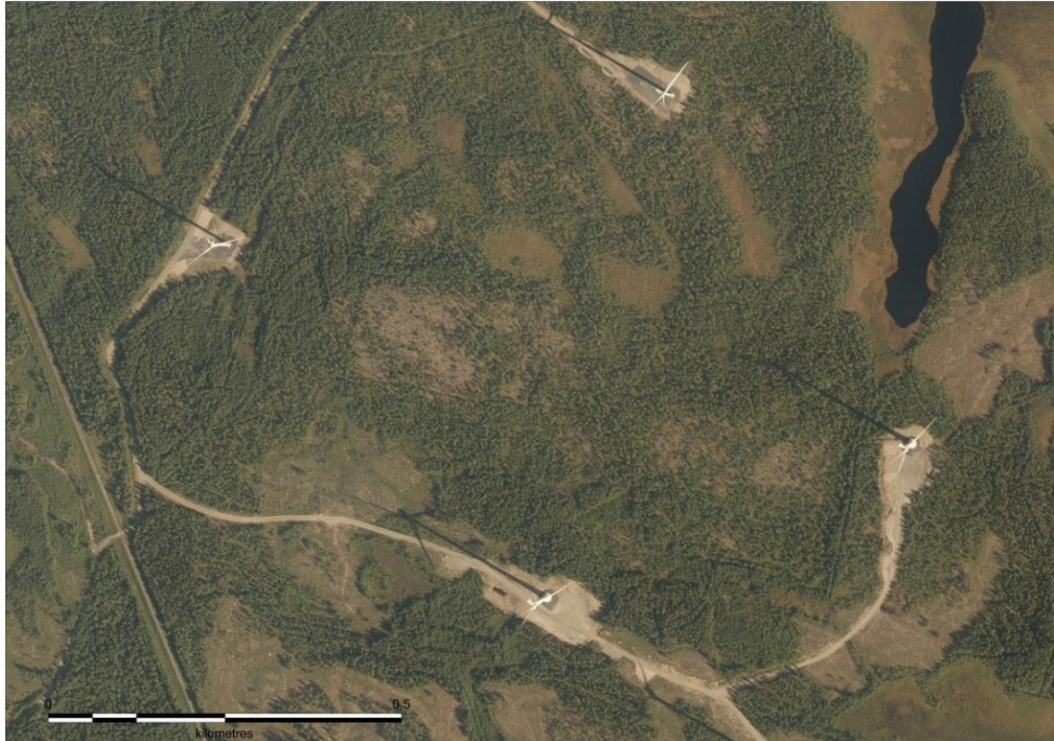
Kuva 5-1 Ilmakuva rakennetusta tuulivoimahankkeesta (Maanmittauslaitos). Kuva ei ole Karhukorven hanke-alueelta.
