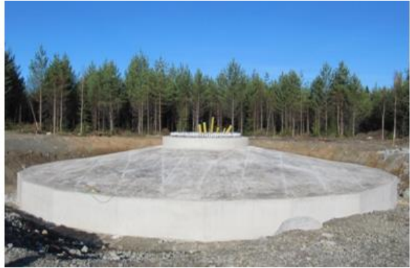
Kuva 5-14 Tuulivoimalan perustusten rakentamista (FCG Finnish Consulting Group Oy).
