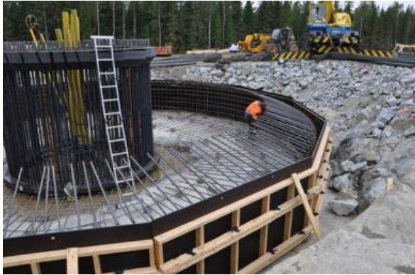
Kuva 5-14 Tuulivoimalan perustusten rakentamista (FCG Finnish Consulting Group Oy).
