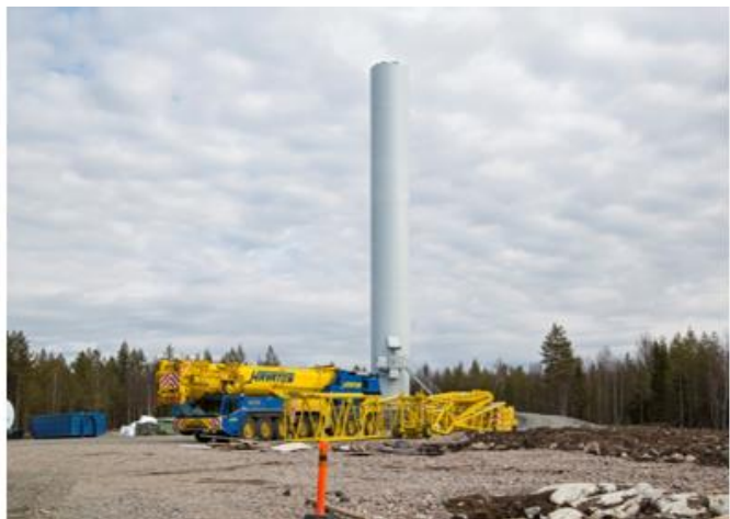
Kuva 5-15 Tuulivoimalan kokoamista (FCG Finnish Consulting Group Oy).
