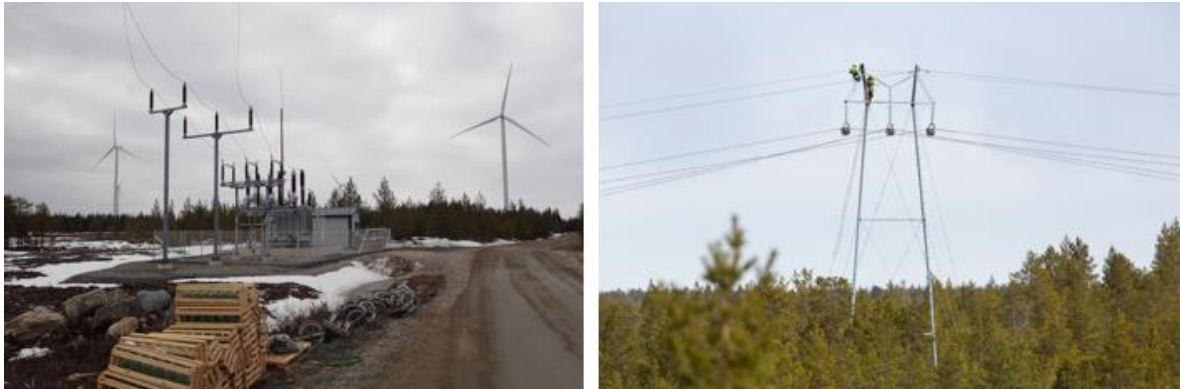
Kuva 5-17 Sähköaseman ja voimajohdon rakentamista (FCG Finnish Consulting Group Oy).
