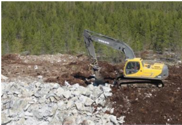
Kuva 5-12 Tuulivoimaloiden rakentaminen alkaa huoltoteiden ja pystytysalueiden rakentamisella (FCG Finnish Consulting Group Oy).
