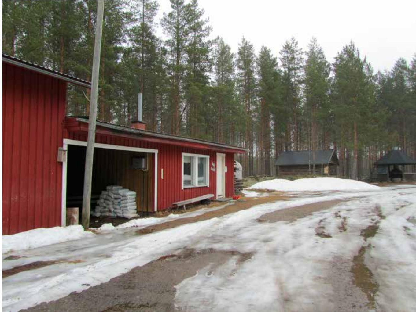
Kuva 35. Hankealueella sijaitseva Kannuksen metsästysseuran rakennus. © Erika Kylmänen.
