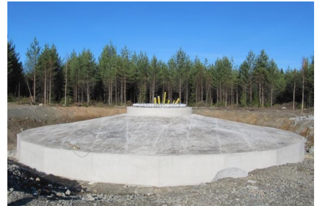
Kuvapari 2-16. Tuulivoimalan perustusten rakentamista. (Kuvat: Leila Väyrynen, FCG)
