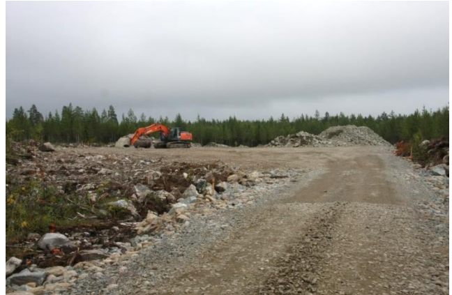
Kuvapari 2-14. Tuulivoimapuiston rakentaminen alkaa huoltoteiden ja pystytysalueiden rakentamisella (kuvat: Ville Suorsa, FCG).
