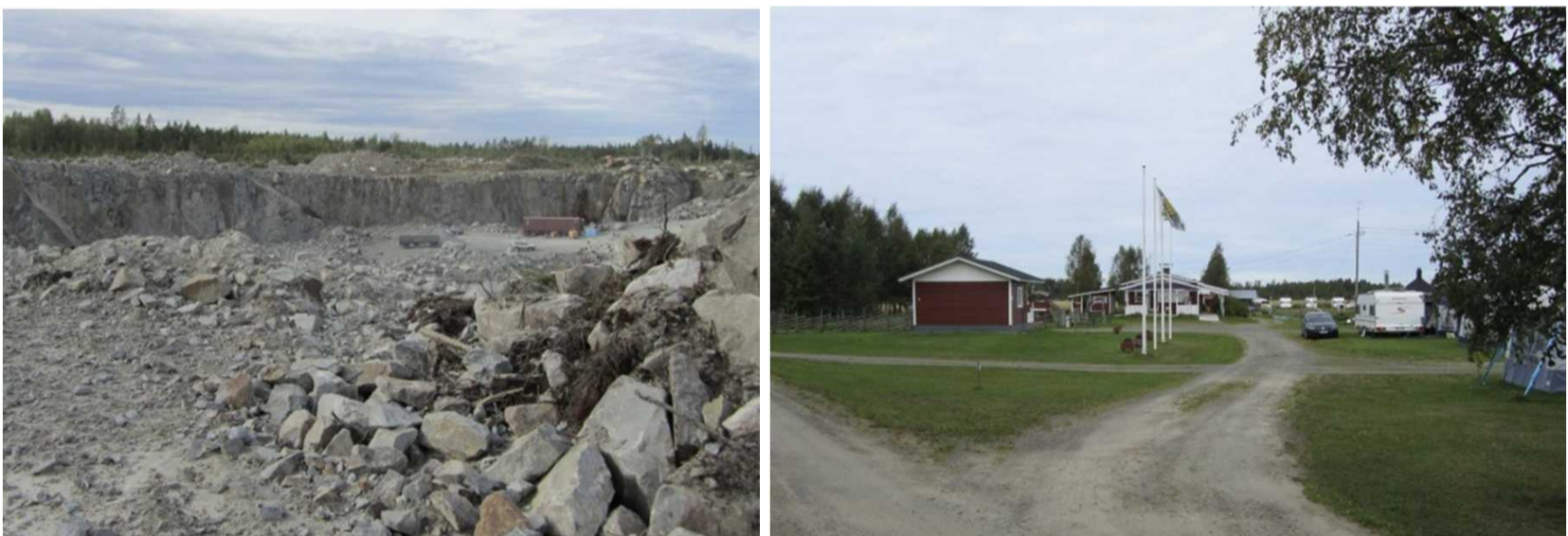
Kuva 17. Kalliomurskeen ottoalue Hummastinvaaralla hankealueen länsirajalla (vasemmalla) sekä camping-alue Multaranta hankealueen lounaispuolella.
