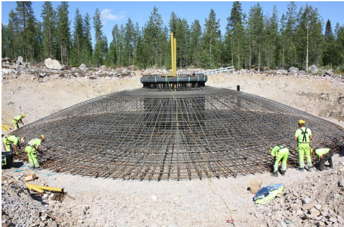
Kuva 9. Maanvarainen teräsbetoniperustus raudoitettuna ennen betonivalua, Tervola (Ramboll Finland Oy 2013).
