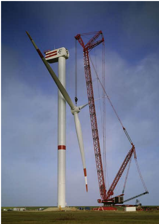
Kuva 14. Tuulivoimalan pystytys tela-alustaisella nosturilla (Liebherr).
