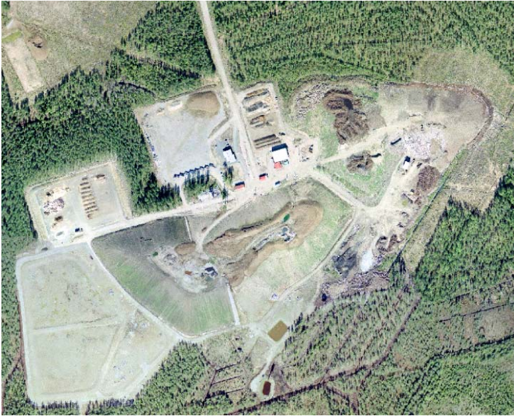
Kuva 5. Ilmakuva Majasaarenkankaan jätekeskuksesta.
