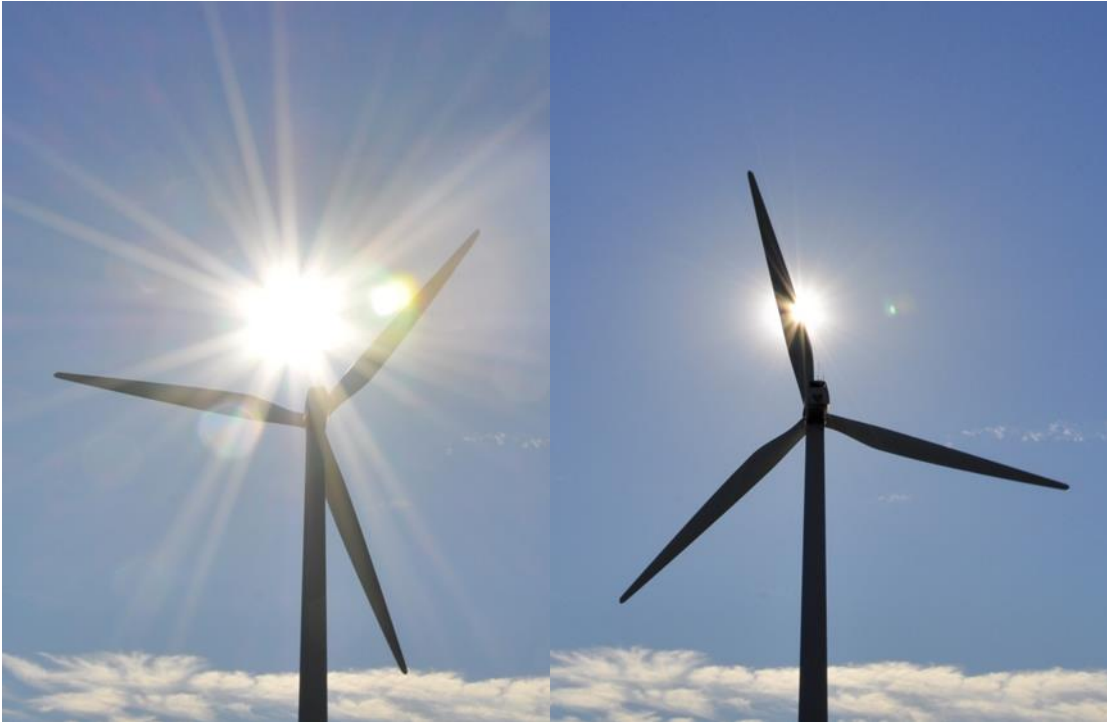
Kuva 16.12. Tuulivoimaloiden lavat aiheuttavat pyöriessään vilkkumista ja varjon välkkymistä aurinkoisella säällä.
