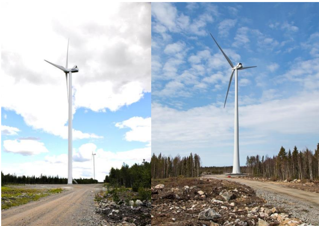
Kuvapari 4.2. Vasemmalla on esimerkki teräslieriötornista ja oikealla hybriditornista (Kuvat: FCG).
