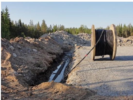
Kuvapari 4.14. Maakaapelit upotetaan huoltoteiden yhteyteen (Kuvat: FCG).
