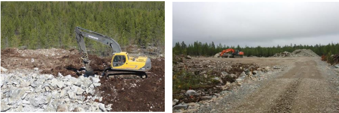
Kuvapari 4.13. Tuulivoimapuiston rakentaminen alkaa huoltoteiden ja pystytysalueiden rakentamisella (Kuvat: FCG).
