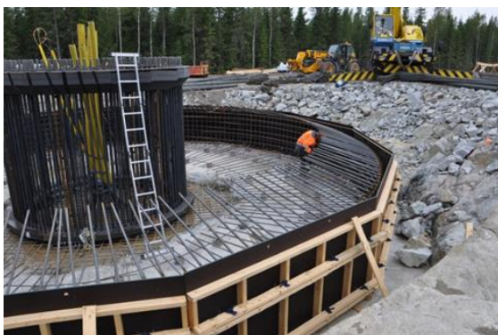
Kuvapari 4.15. Tuulivoimalan perustusten rakentamista (Kuvat: FCG).
