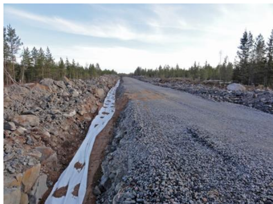
Kuvapari 4.14. Maakaapelit upotetaan huoltoteiden yhteyteen (Kuvat: FCG).
