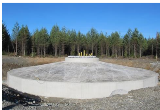
Kuvapari 4.15. Tuulivoimalan perustusten rakentamista (Kuvat: FCG).
