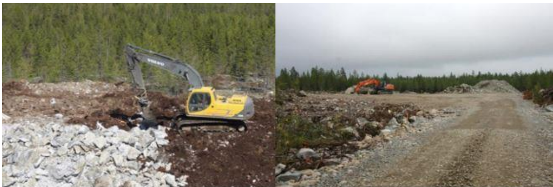
Kuva 19. Tuulivoimapuiston rakentaminen alkaa huoltoteiden ja pystytysalueiden rakentamisella (Ville Suorsa, FCG).
