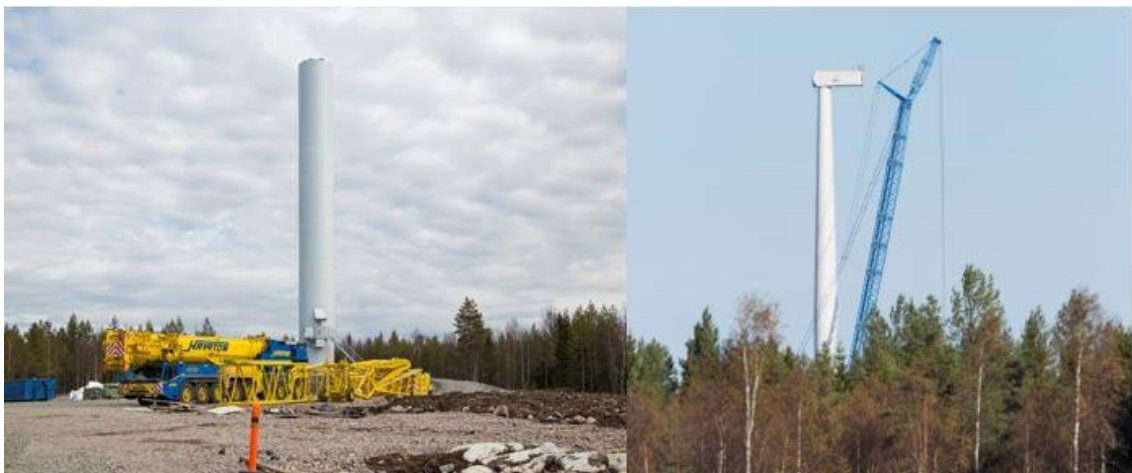
Kuva 22. Tuulivoimalan kokoamista (Ville Suorsa, FCG).
