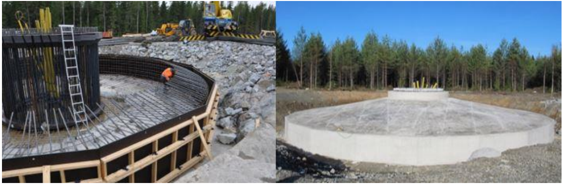
Kuva 21. Tuulivoimalan perustusten rakentamista (Leila Väyrynen, FCG).
