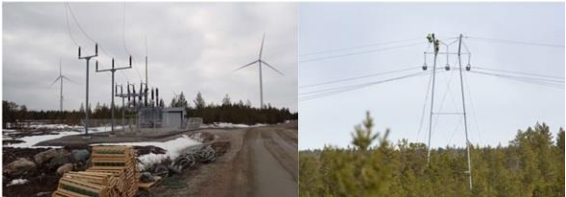
Kuva 24. Sähköaseman ja voimajohdon rakentamista (Ville Suorsa, FCG).
