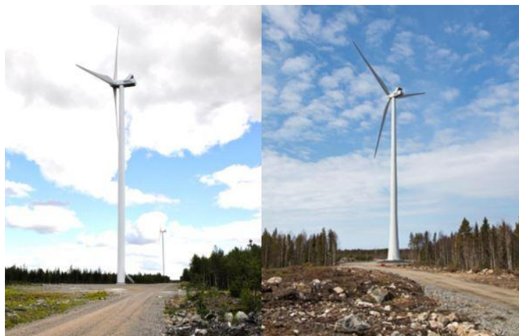
Kuva 13. Vasemmalla on esimerkki teräslieriötornista ja oikealla hybriditornista (Leila Väyrynen ja Ville Suorsa, FCG).
