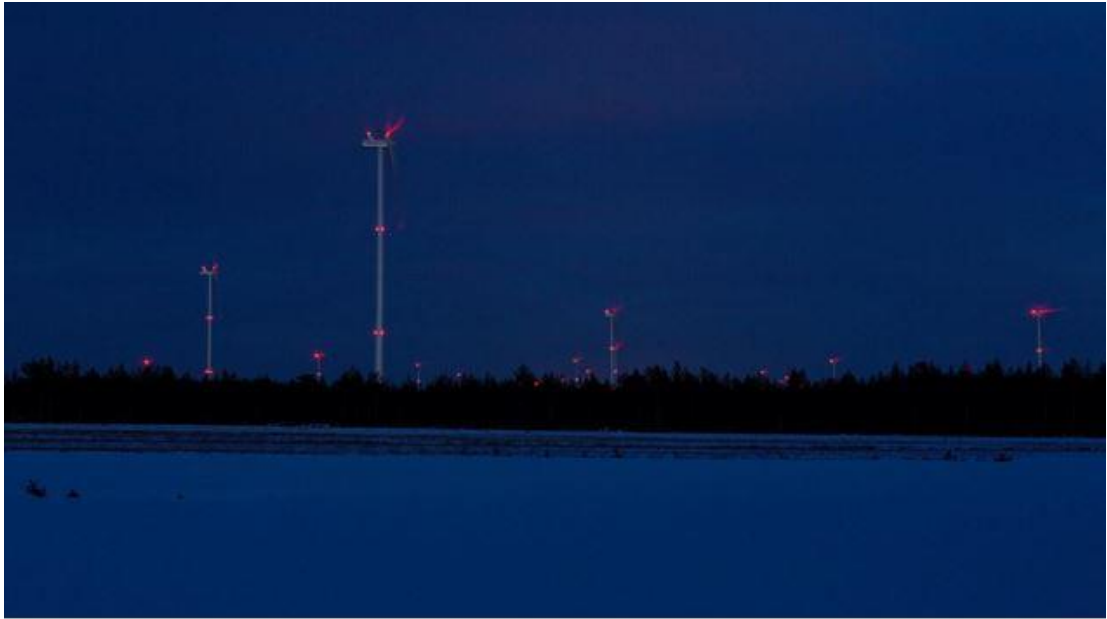
Kuva 14. Kiinteät punaiset lentoestevalot (Ville Suorsa, FCG).
