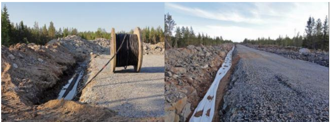
Kuva 20. Maakaapelit upotetaan huoltoteiden yhteyteen (Ville Suorsa, FCG).
