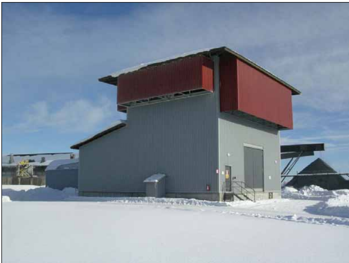
Kuva 4-12. Raitisilman pumppausasema Pyhäsalmen kuparikaivoksella
