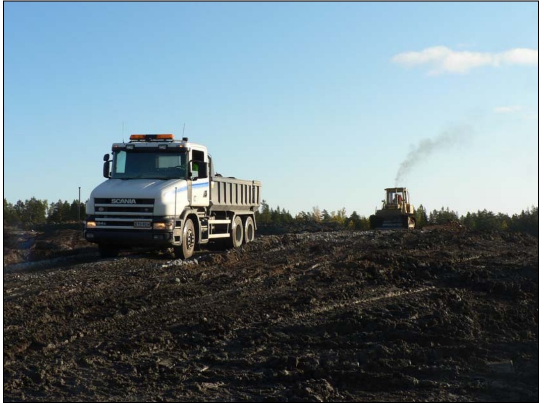
Kuva 9. Ylijäämämassojen kuormat tuodaan kuorma-autoilla maanvastaanottoalueen läjitysalueelle, jossa massat siirretään ja tiivistetään puskutraktorilla.
