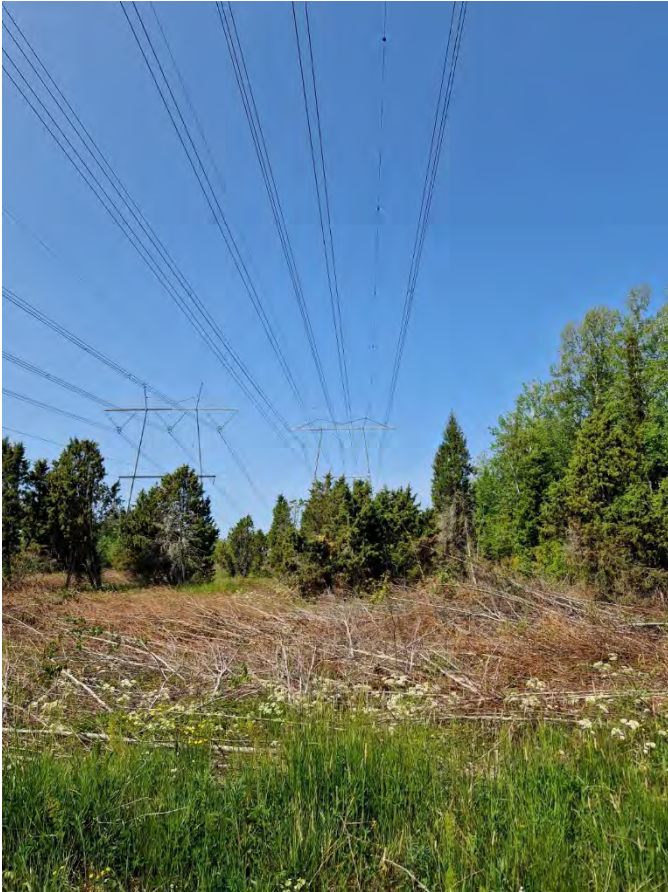
Kuva 14. Esimerkki valikoivasta raivauksesta.
