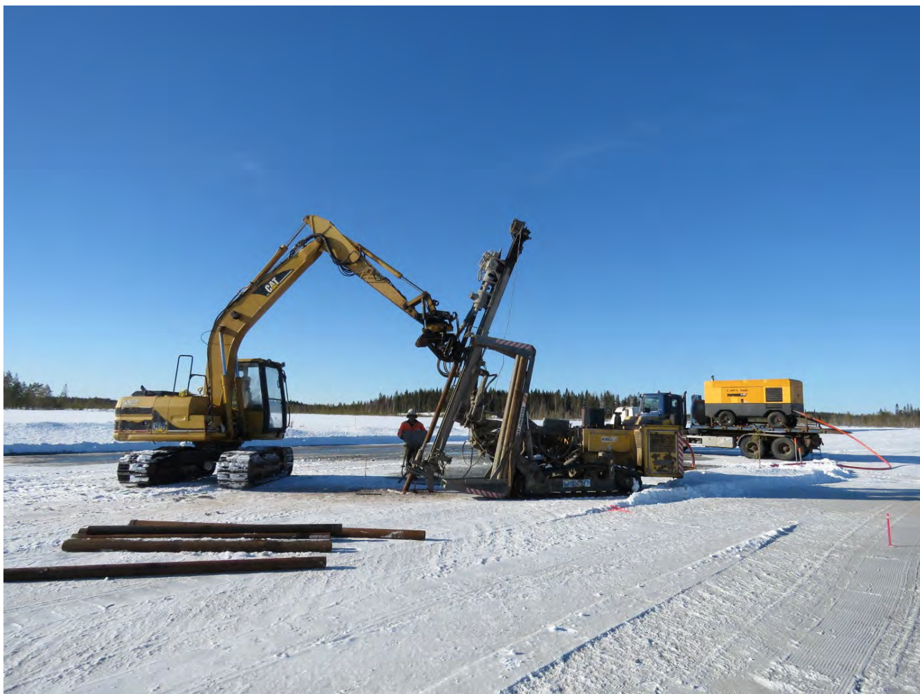
Kuva 12. Porapaaluperustuksen tekoa suoalueella, jossa työalue on jäädytetty.
