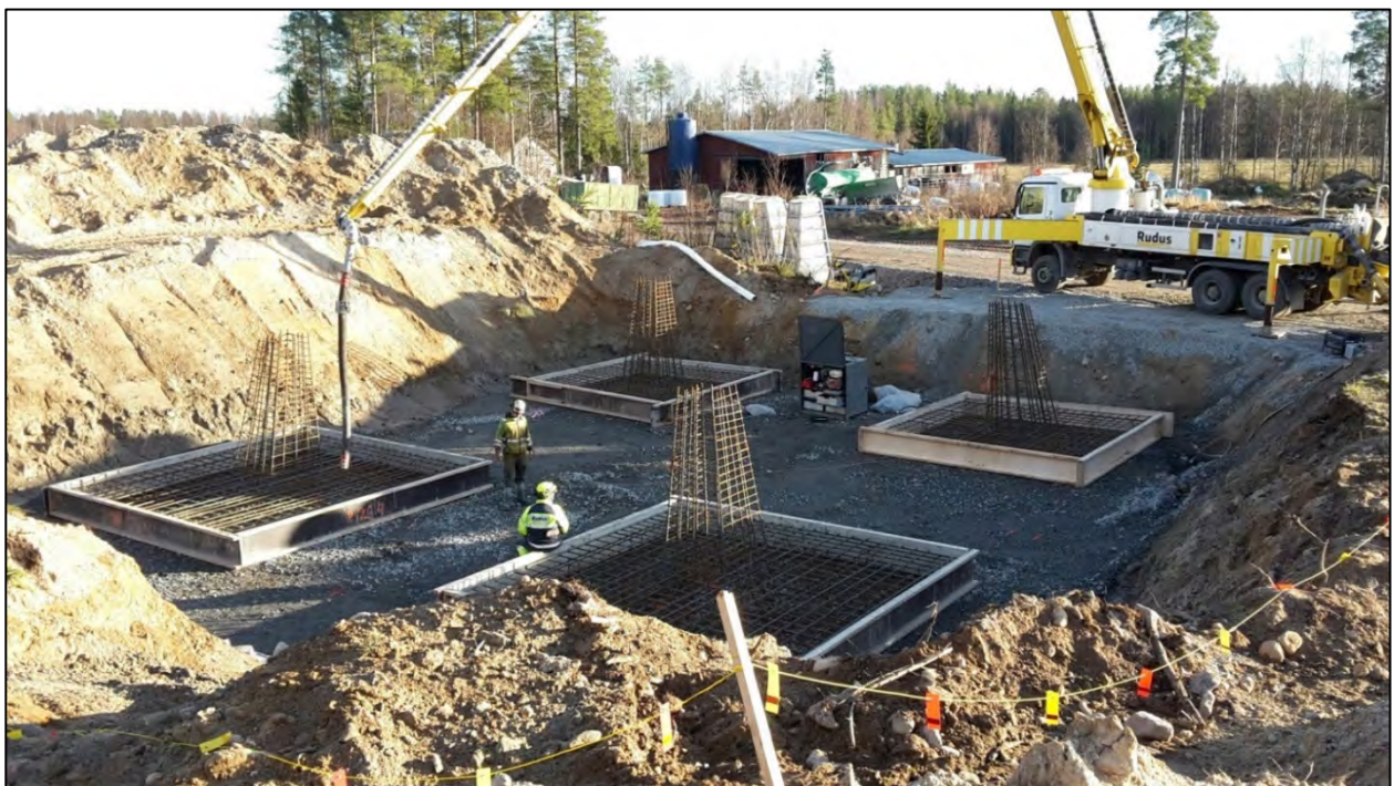
Kuva 11. Vapaasti seisovan pylvään perustuksen pohjatöitä.
