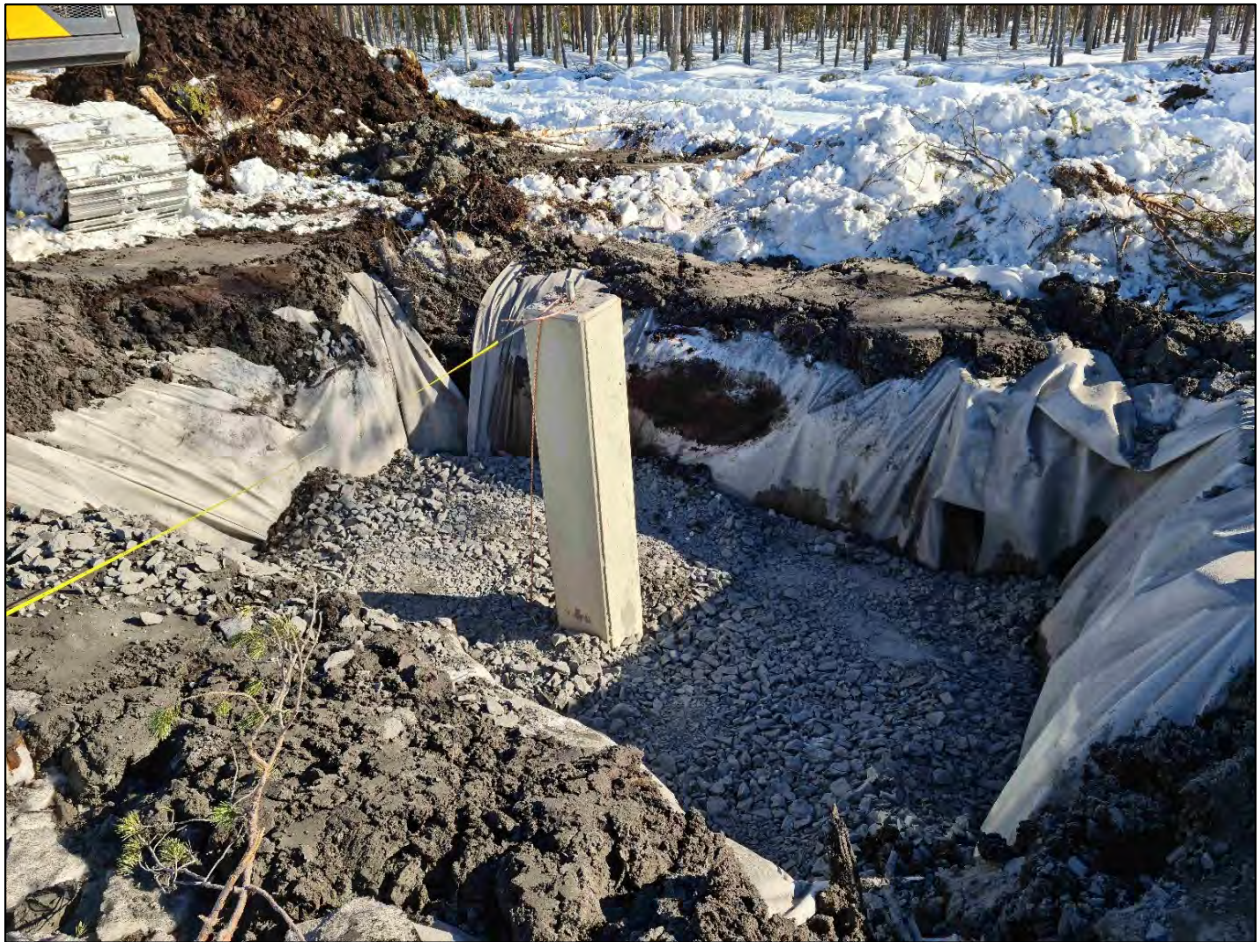
Kuva 10. Pylvään perustuselementin asentaminen.
