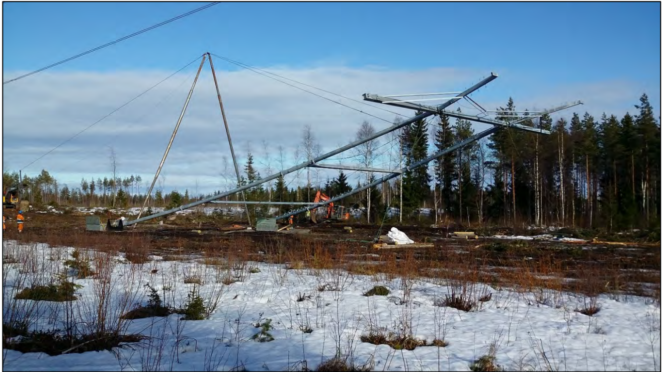
Kuva 13. Voimajohtopylvään pystytys.
