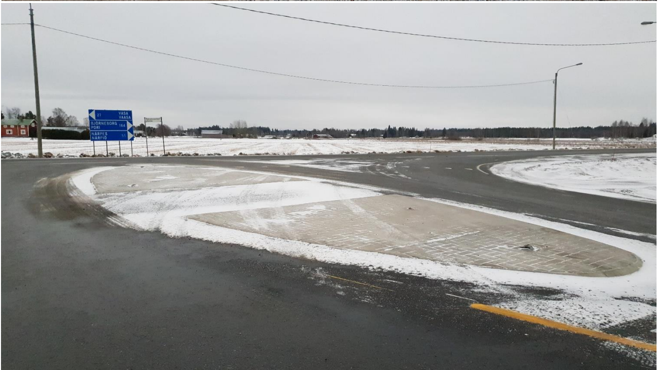
Kuvat 11 ja 12. Yllä tuulivoimapuiston huoltotieverkko rakenteilla. Alempi kuva valtatie 8:n ja Maalahdentien risteyksestä. Pitkät kuljetukset vaativat suuren kääntösäteen ja ne voivat ylittää erikoiskuljetuksia silmällä pitäen rakennetun matalan liikenteenjakajan. Kuvat: Toni Lustila
