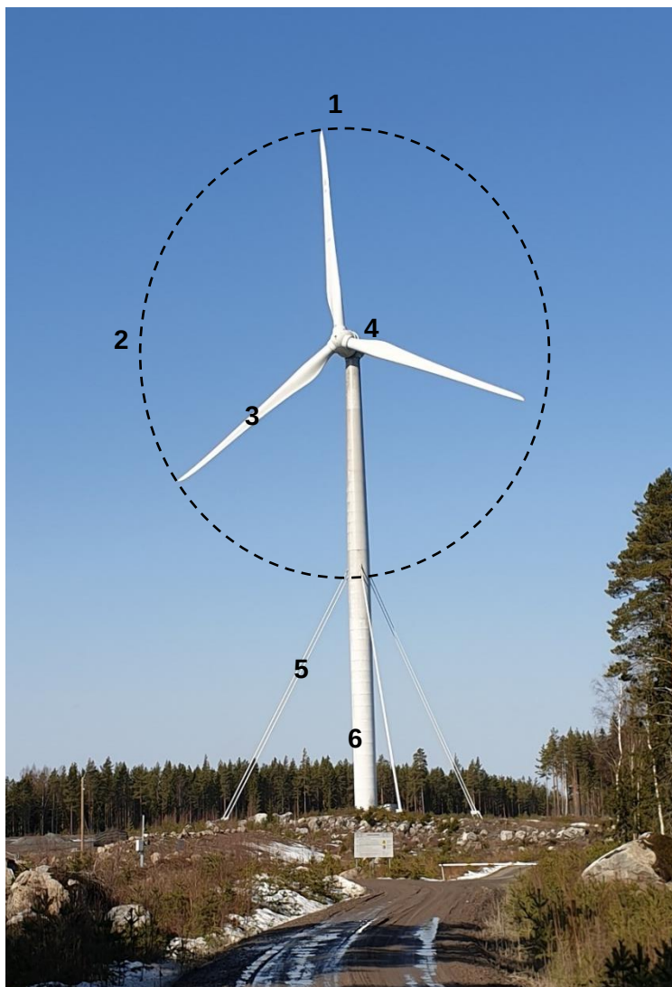
Kuva 8. Tuulivoimalan rakenne ja termit: 1) kokonaiskorkeus 2) roottori, roottorin halkaisija 3) lapa 4) naselli, konehuone, napakorkeus 5) mahdolliset harukset 6) torni
