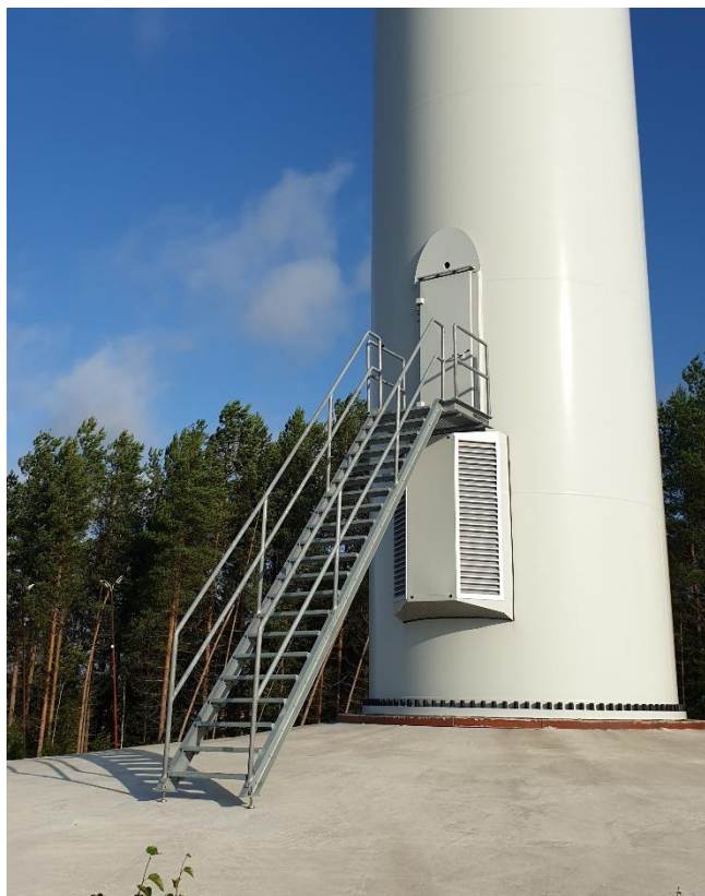
Kuva 10. Tuulivoimalan sisäänkäynti. Kuva: Toni Lustila
