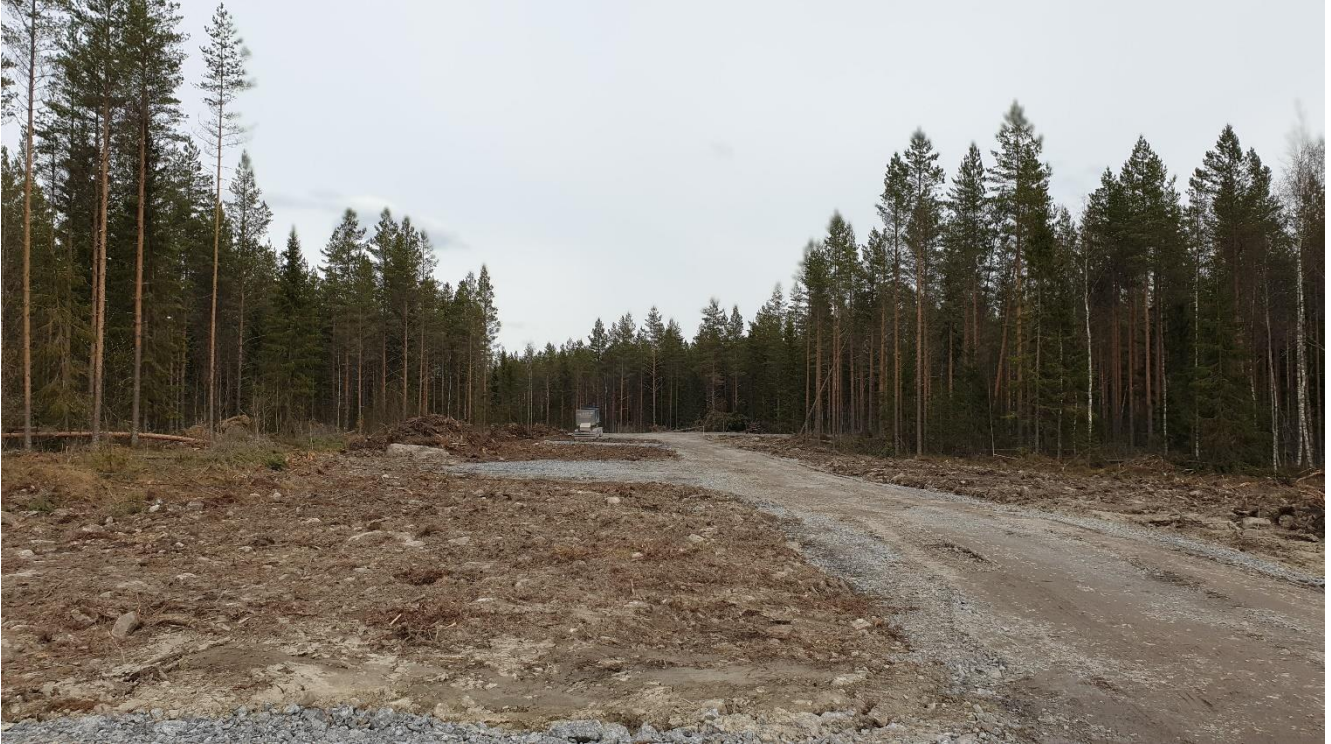
Kuva 15. Kuva rakenteilla olevasta nostoalueesta. Etualalla apunosturin työskentelyä varten sorastet- tuja alueita. Tuulivoimalan rakennuspaikka ja päänosturin työskentelyalue sijaitsevat nostoalueen pe- rällä. Kuva: Toni Lustila
