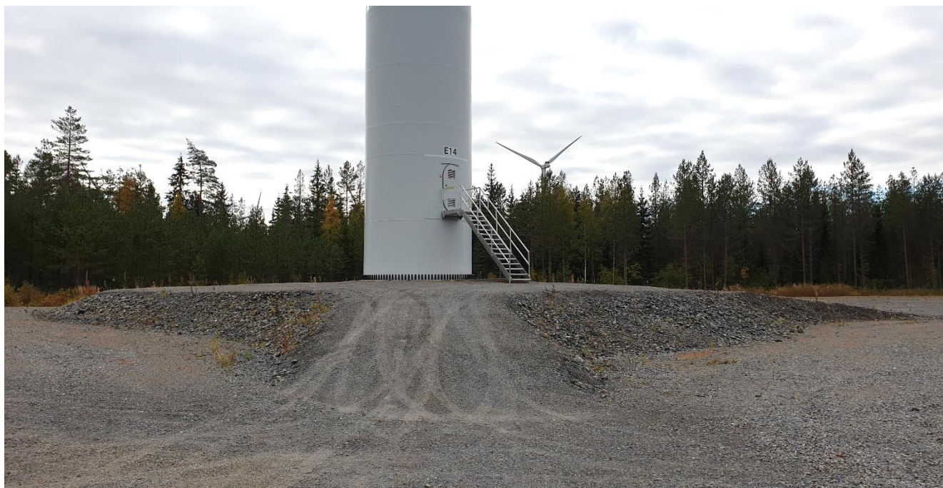
Kuva 9. Esimerkki murskeella peitetystä maanvaraisesta teräsbetoniperustuksesta. Kuva: Toni Lus-tila
