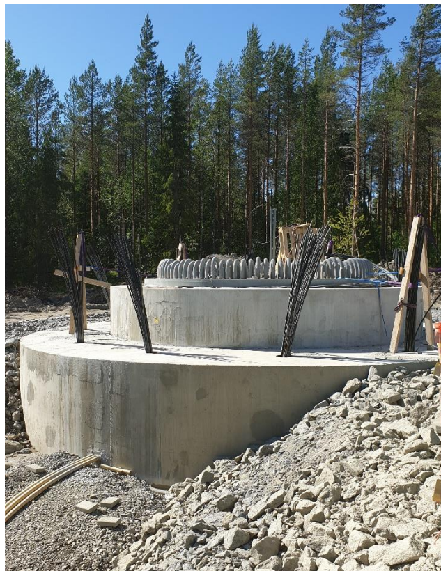
Kuva 11. Kallioankkuroitu perustus rakenteilla. Kuva: Toni Lustila
