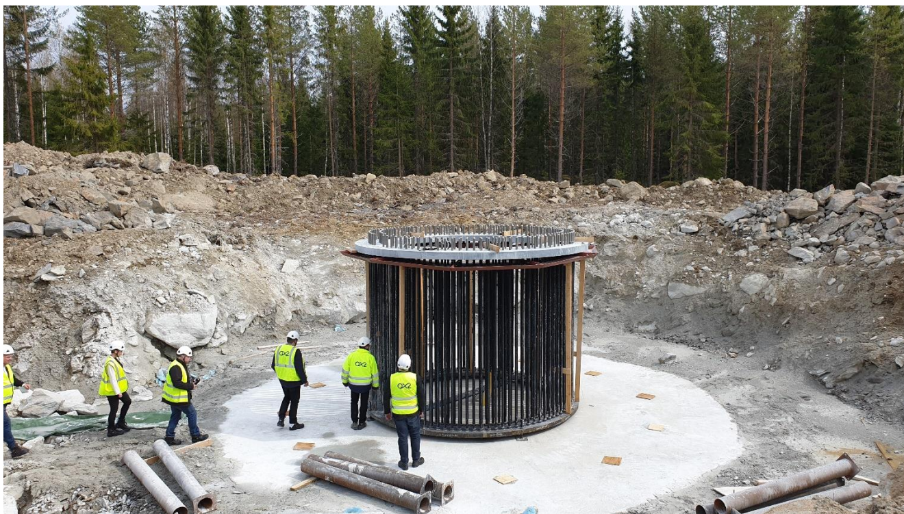
Kuva 19. Tuulivoimatyömaalla pukeudutaan heijastaviin vaatteisiin. Kypärä, turvajalkineet, kuulosuojaimet ja suojalasit ovat myös työturvallisuuden kannalta välttämättömät suojavarusteet. Kuvassa rakennetaan tuulivoimalan kallioankkuriperustusta. Kaivumassat on sijoitettu väliaikaisesti kaivannon reunoille. Kuva: Toni Lustila
