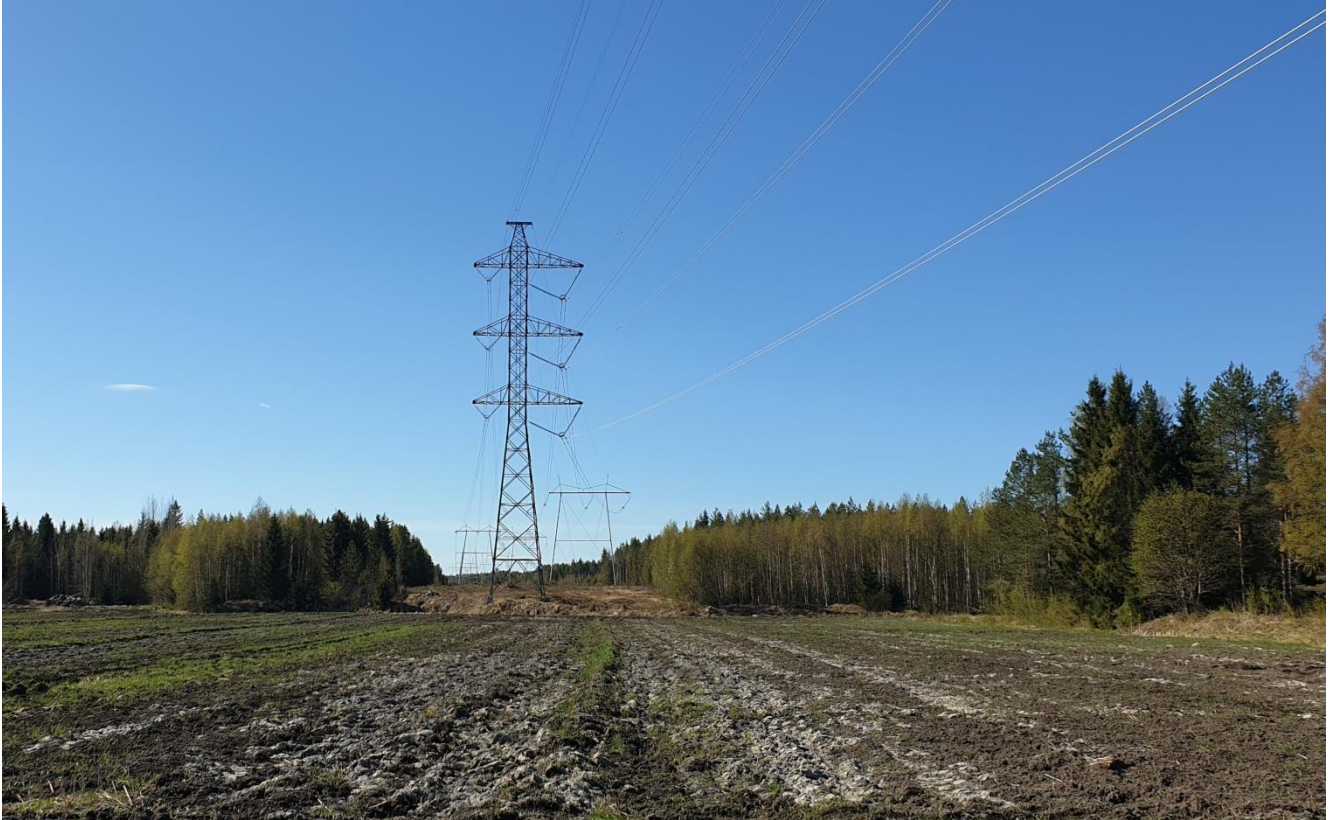
Kuva 18. Kuva Pitkäloukon alueelta Fingridin 400 ja 220 kV:n voimajohdoista. Taustalla voimajohdot kulkevat rinnan harustettujen portaalipylväiden varassa ja etualalla voimajohdot kuljetetaan maankäyttöön liittyvistä syistä yhdessä teräspylväässä, jolloin tilantarve on pienempi. Kuva: Toni Lustila
