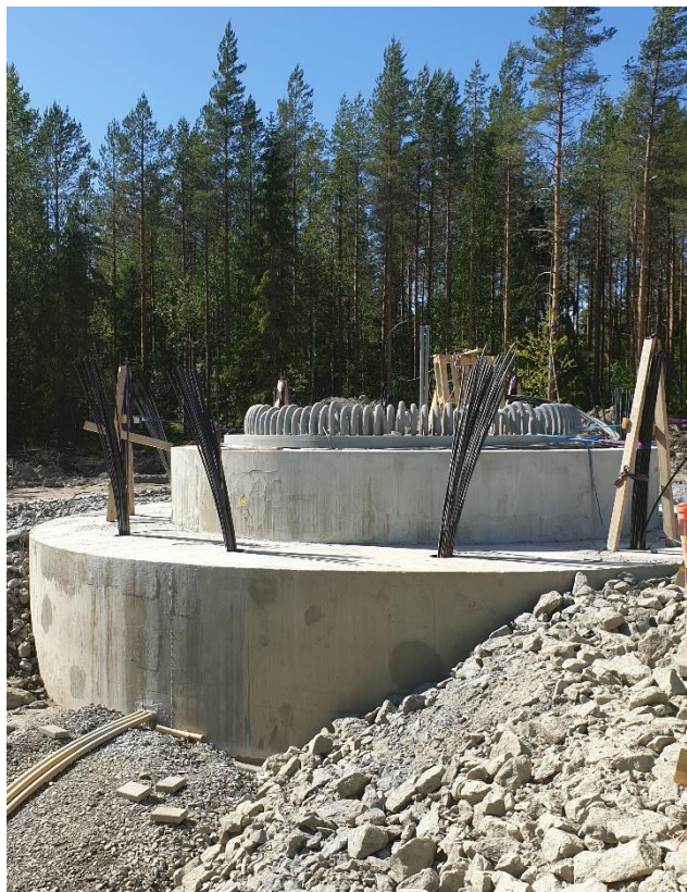
Bild 11. Ett bergförankrat fundament under konstruktion. Bild: Toni Lustila
