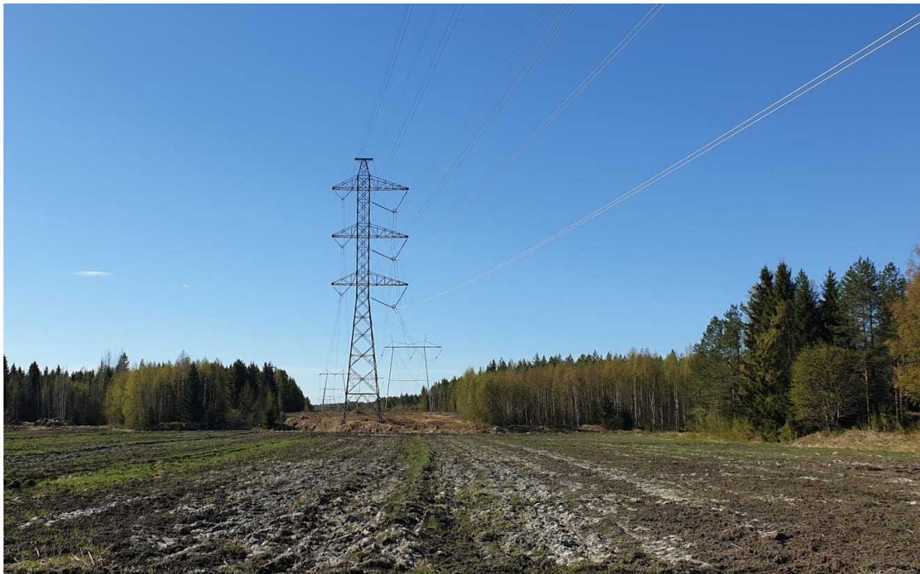
Bild 18. Bild på Fingrids 400 och 220 kV kraftledning i området Pitkäloukko. I bakgrunden går kraftledningarna bredvid varandra i stagade portalstolpar och i förgrunden, på grund av markanvändningsorsaker, i en stålstolpe varvid utrymmesbehovet är mindre. Bild: Toni Lustila
