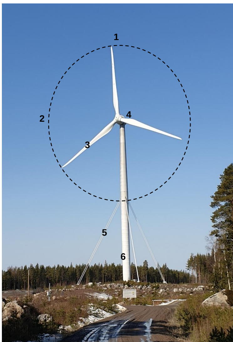
Bild 8. Vindkraftverkets konstruktion och termer: 1) totalhöjd 2) rotor, rotordiameter 3) blad 4) nasell, maskinhus, navhöjd 5) eventuella stag 6) torn.
