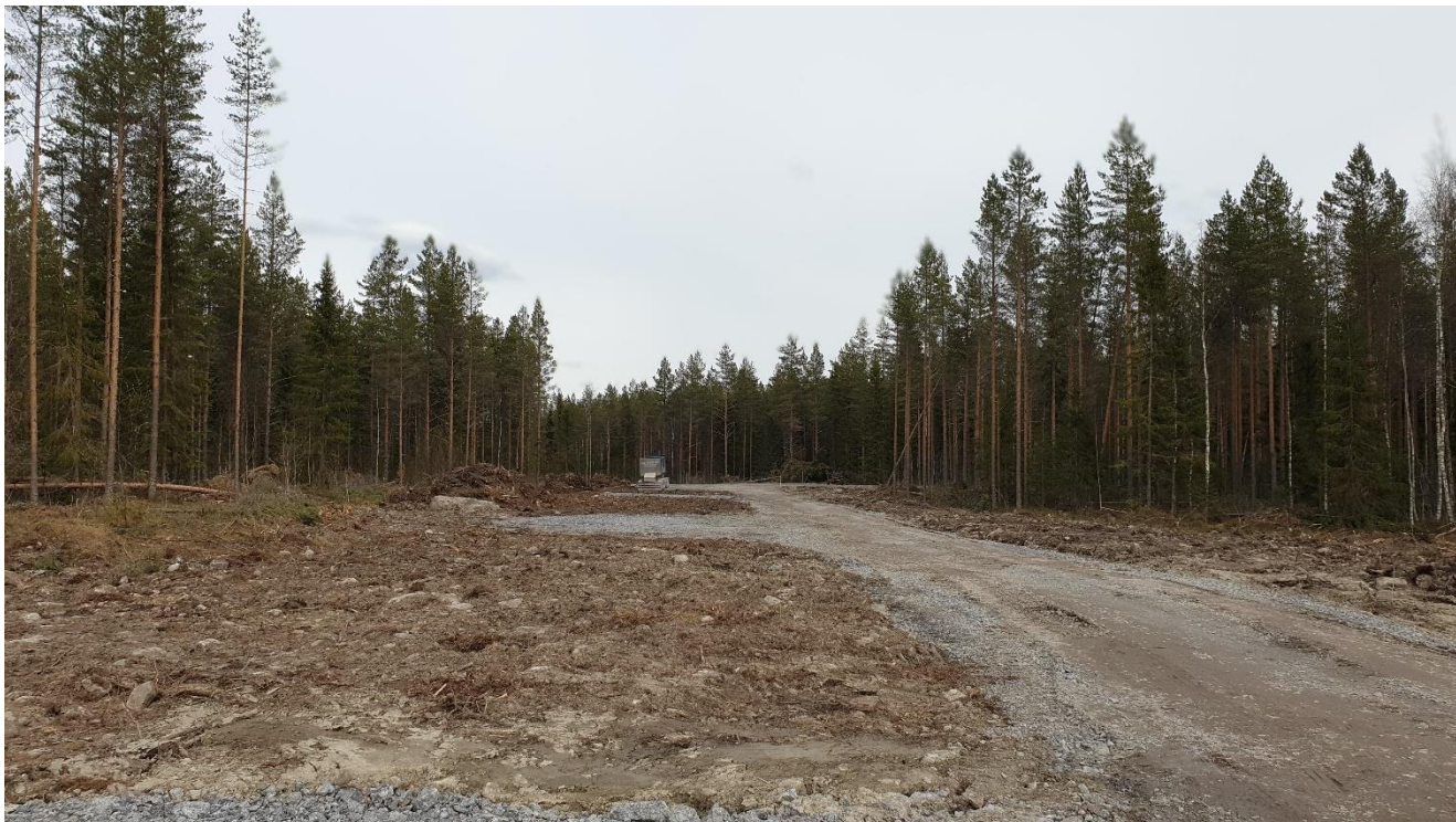
Bild 15. Bild på ett lyftområde som är under konstruktion. I förgrunden visas grusade områden för uppställning av hjälpkran. Vindkraftverkets etableringsplats och huvudkranens arbetsyta ligger i den borte änden av lyftområdet. Bild: Toni Lustila
