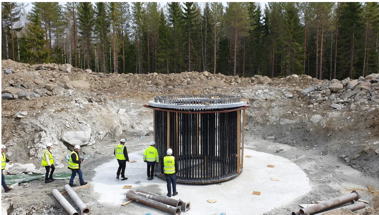
Bild 19. På vindkraftsarbetsplatsen används kläder med reflex. Med tanke på arbetssäkerheten är hjälm, skyddsskor, hörselskydd och skyddsglasögon nödvändig skyddsutrustning. Grävmassorna har tillfälligt placerats på kanten av utgrävningen. Bild: Toni Lustila
