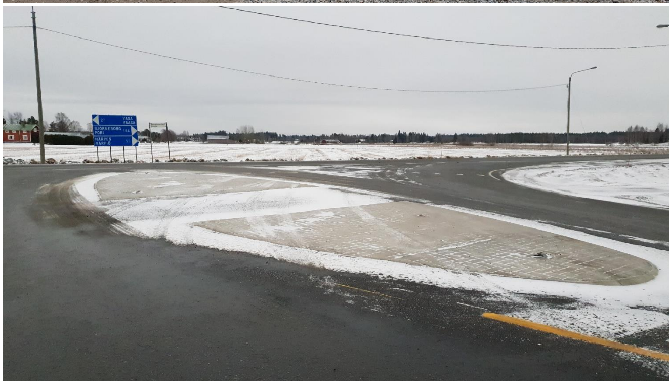
Bild 11 och 12. Bilden ovan visar vindkraftparkens servicevägnät under byggnad. Bilden nedan visar korsningen mellan Riksväg 8 och Malaxvägen. Långa transporter kräver en stor svängradie och de kan korsa låga refuger som byggts med tanke på specialtransporter. Bilder: Toni Lustila
