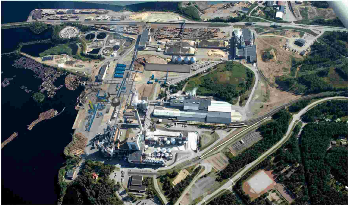
Kuva 7-17. Havainnekuva biojalostamon sijoittumisesta tehdasalueelle. Uudet rakenteet on merkitty sinisellä.
