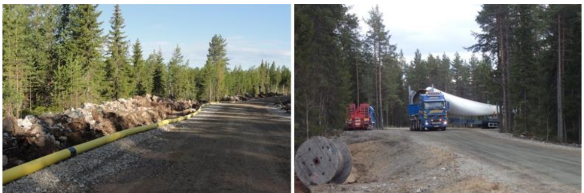
Kuva 5-7 Vasemmalla esimerkki tuulivoimahankkeen rakennus- ja huoltotiestä. Oikealla tuulivoimalan osia kuljetetaan erikoiskuljetuksina (FCG Finnish Consulting Group Oy).
