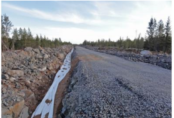
Kuva 5-13 Maakaapelit upotetaan huoltoteiden yhteyteen (FCG Finnish Consulting Group Oy).
