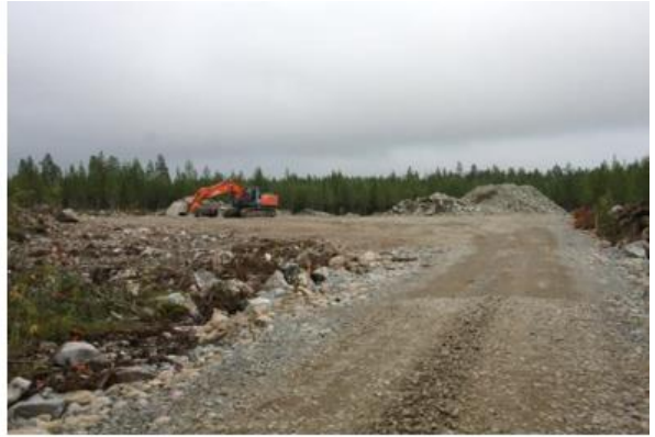
Kuva 5-12 Tuulivoimaloiden rakentaminen alkaa huoltoteiden ja pystytysalueiden rakentamisella (FCG Finnish Consulting Group Oy).
