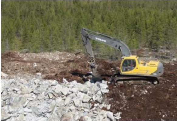
Kuva 5-12 Tuulivoimaloiden rakentaminen alkaa huoltoteiden ja pystytysalueiden rakentamisella (FCG Finnish Consulting Group Oy).
