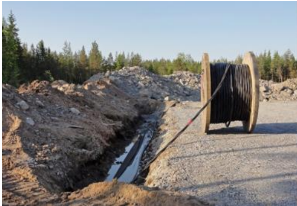
Kuva 5-13 Maakaapelit upotetaan huoltoteiden yhteyteen (FCG Finnish Consulting Group Oy).
