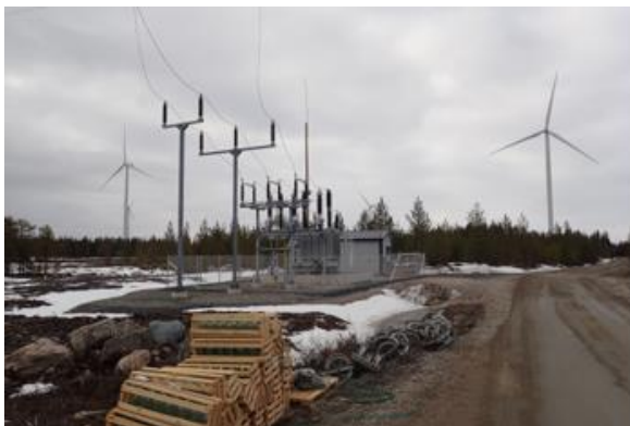
Kuva 5-17 Sähköaseman ja voimajohdon rakentamista (FCG Finnish Consulting Group Oy).
