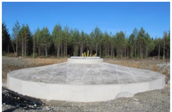
Kuva 5-14 Tuulivoimalan perustusten rakentamista (FCG Finnish Consulting Group Oy).
