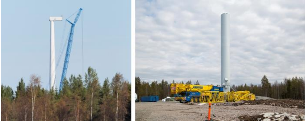
Kuva 5-15 Tuulivoimalan kokoamista (FCG Finnish Consulting Group Oy).
