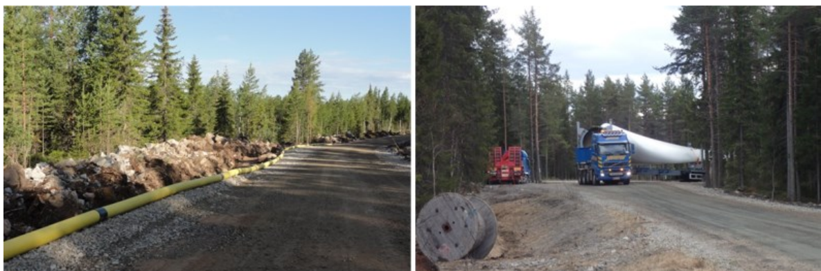
Bild 5.7 Till vänster ett exempel på byggnads- och servicevägar i vindkraftsparken. Till höger delar till vindkraftverk transporteras som specialtransporter (FCG Finnish Consulting Group Oy).
