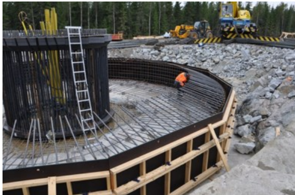
Bild 5.11 Byggande av fundament till vindkraftverk (FCG Finnish Consulting Group Oy).
