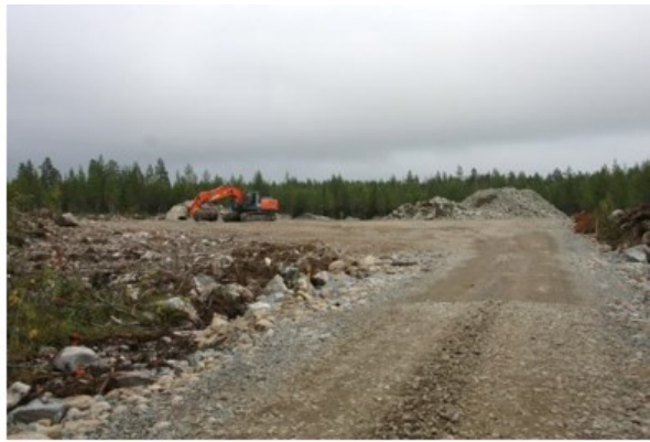
Bild 5.9 Byggandet av vindkraftsparken inleds med att bygga vägar och lyftområden (FCG Finnish Consulting Group Oy).
