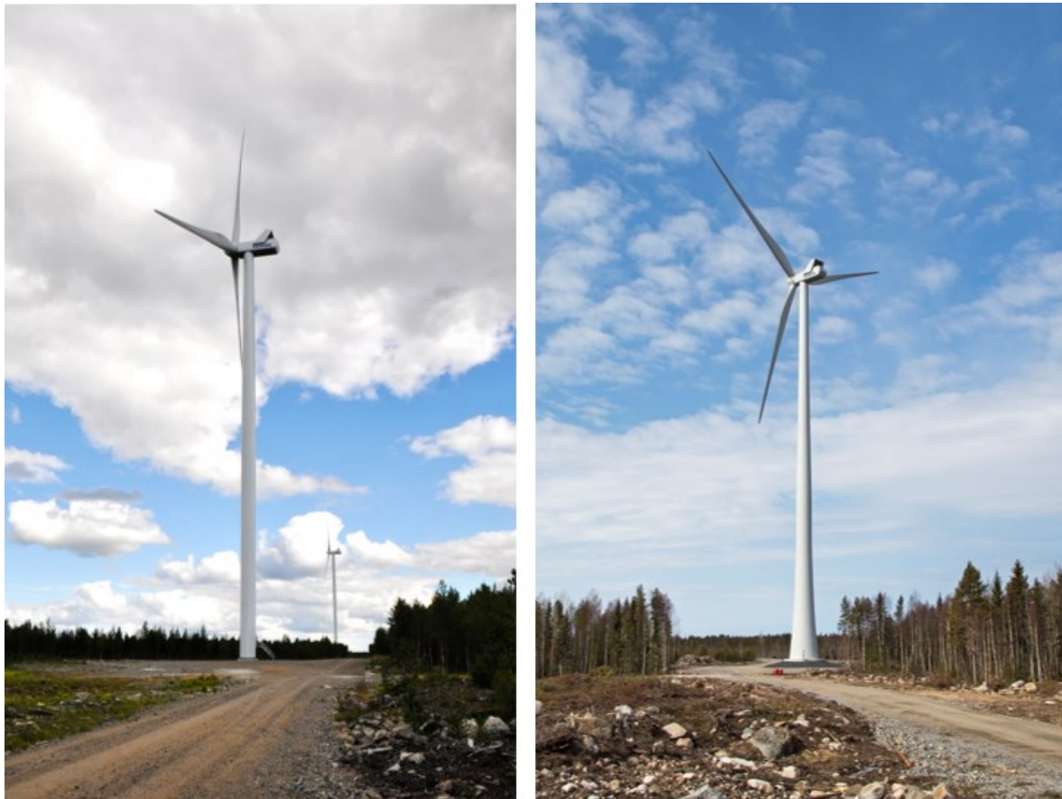
Bild 5.2 Till vänster ett exempel på ett stålcylindertorn och till höger ett hybridtorn (FCG Finnish Consulting Group Oy).
