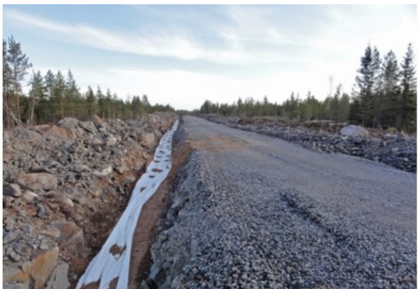
Bild 5.10 Jordkablarna grävs ner i anslutning till servicevägarna (FCG Finnish Consulting Group Oy).
