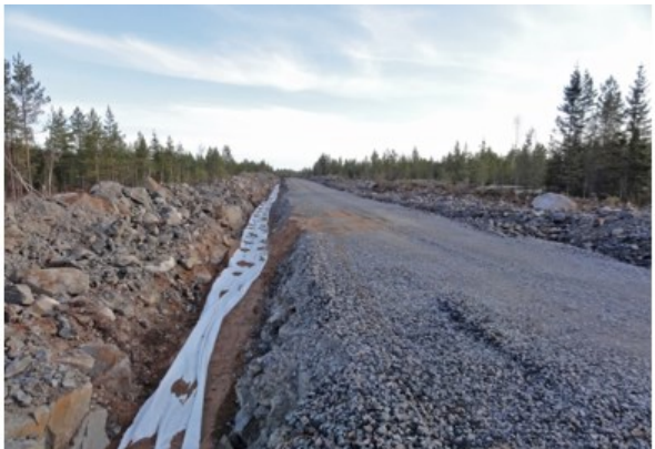
Kuva 5.10 Maakaapelit upotetaan huoltoteiden yhteyteen (FCG Finnish Consulting Group Oy).
