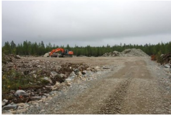
Kuva 5.9 Tuulivoimapuiston rakentaminen alkaa huoltoteiden ja pystytysalueiden rakentamisella (FCG Finnish Consulting Group Oy).
