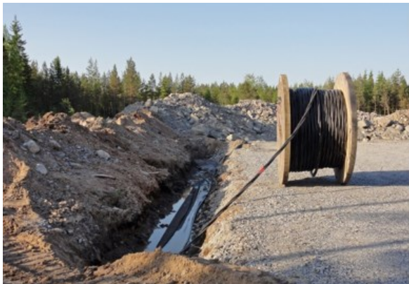
Kuva 5.10 Maakaapelit upotetaan huoltoteiden yhteyteen (FCG Finnish Consulting Group Oy).
