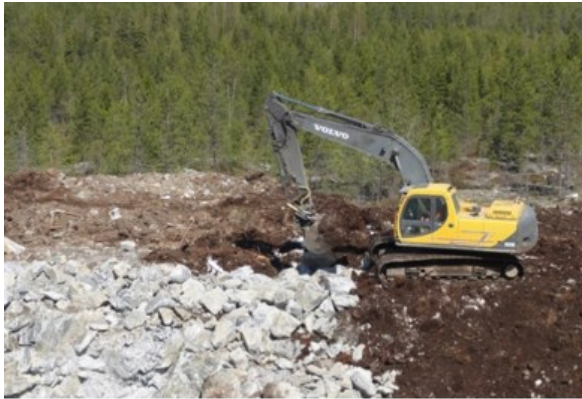
Kuva 5.9 Tuulivoimapuiston rakentaminen alkaa huoltoteiden ja pystytysalueiden rakentamisella (FCG Finnish Consulting Group Oy).
