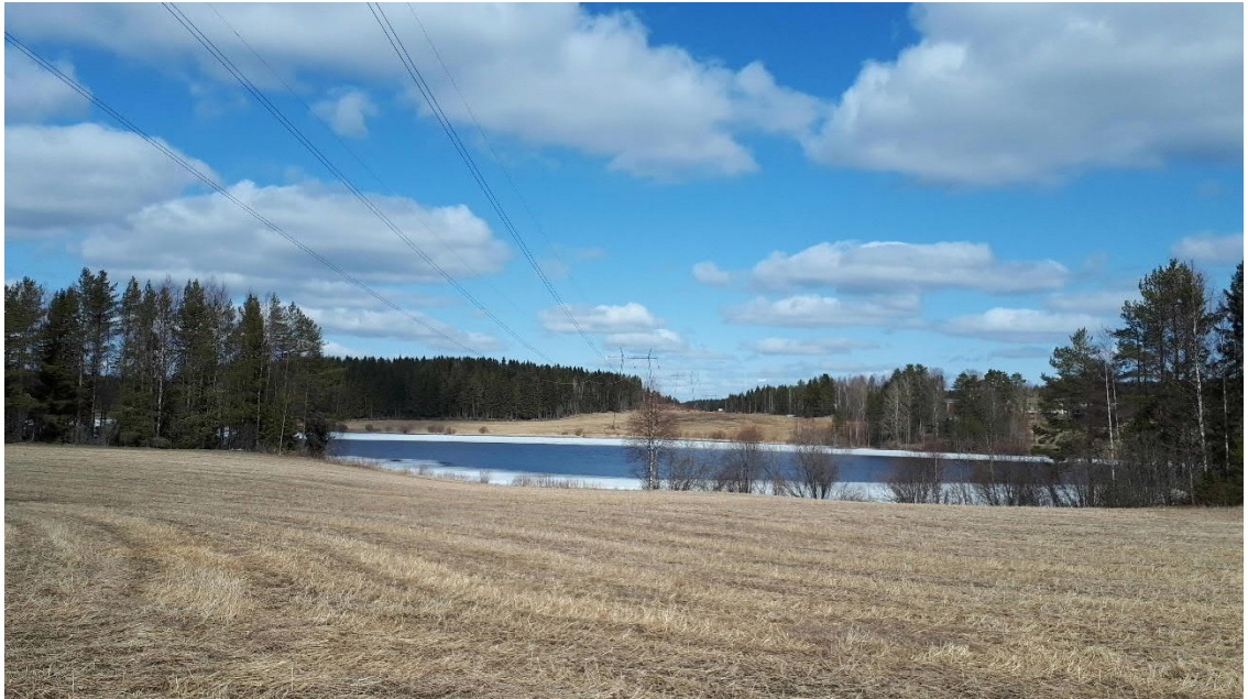
Kuva 5-22. Voimajohdon Koukunjoen ylitys Iisalmessa.
