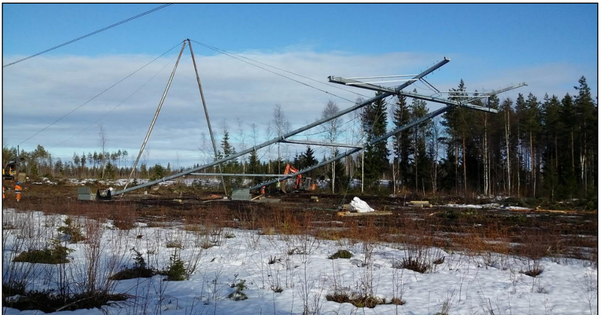
Kuva 3-6. Voimajohtopylvään pystytys.
