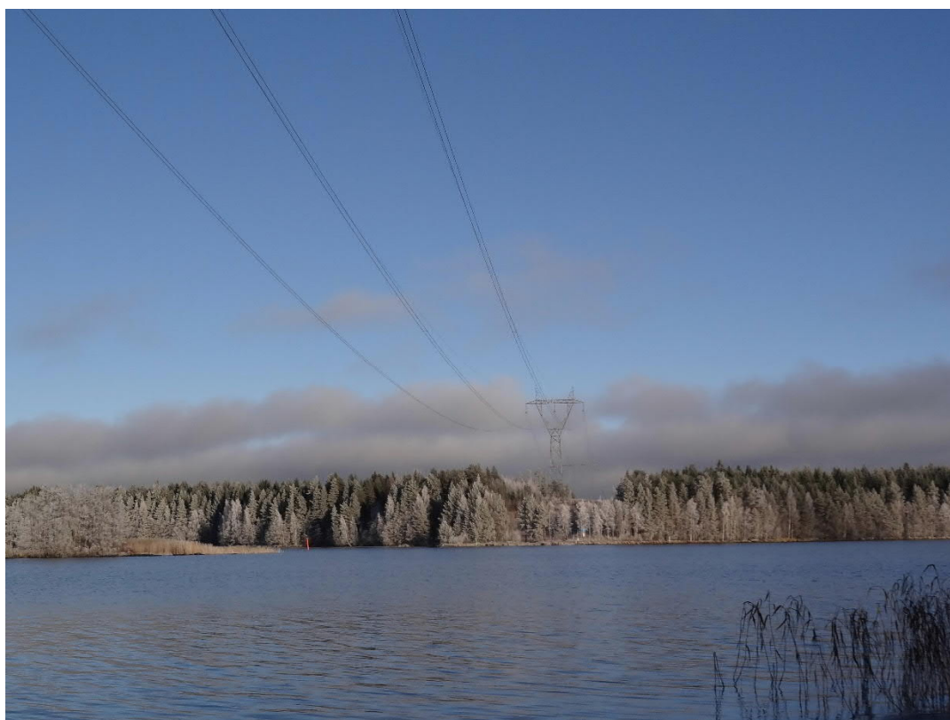
Kuva 5-17. Suunnitellun voimajohdon Kallaveden ylityskohta nykytilassa.
