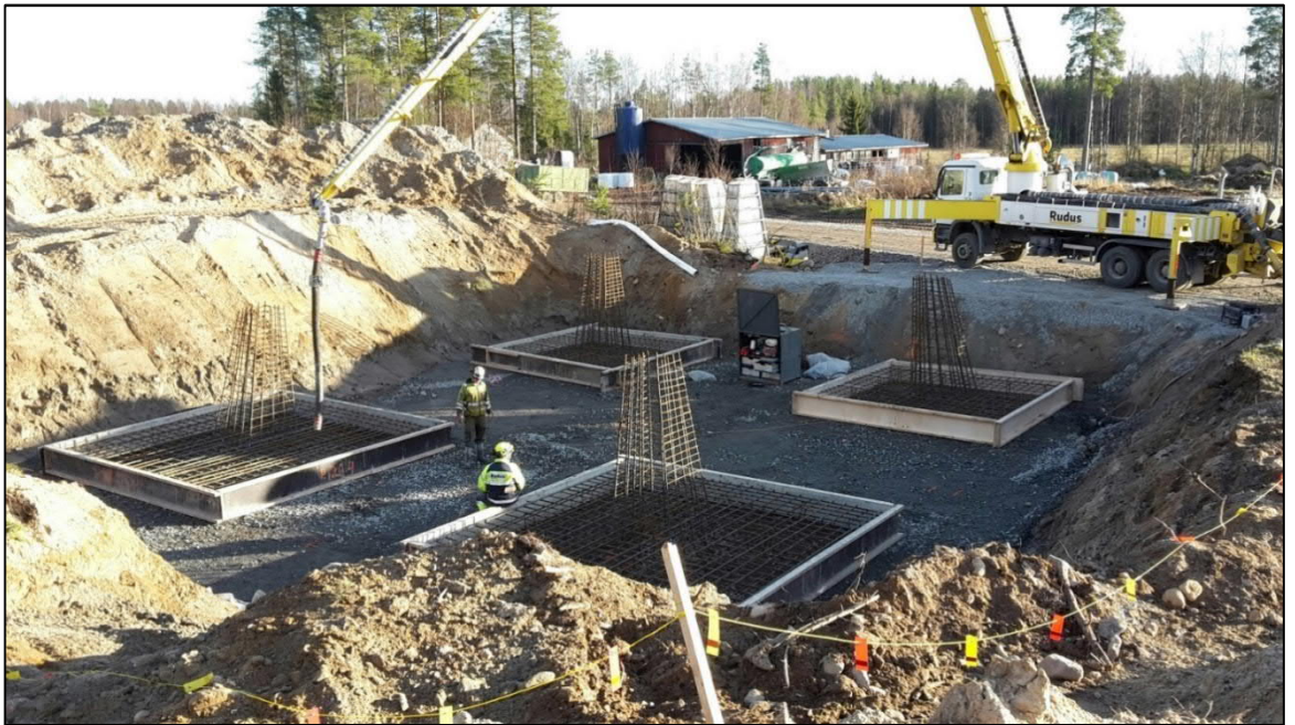
Kuva 3-5. Vapaasti seisovan pylvään perustuksen pohjatöitä.
