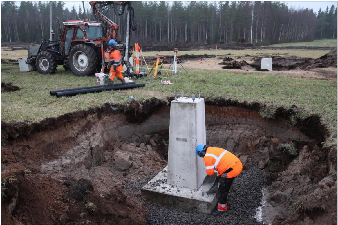
Kuva 3-4. Pylvään perustuselementin asentaminen.
