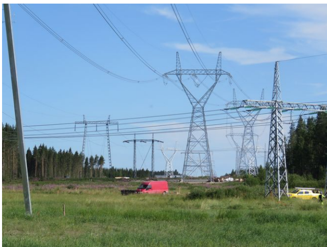
Kuva 33. Haapajärven Pysäysperän uusi sähköasema (rakenteilla)
