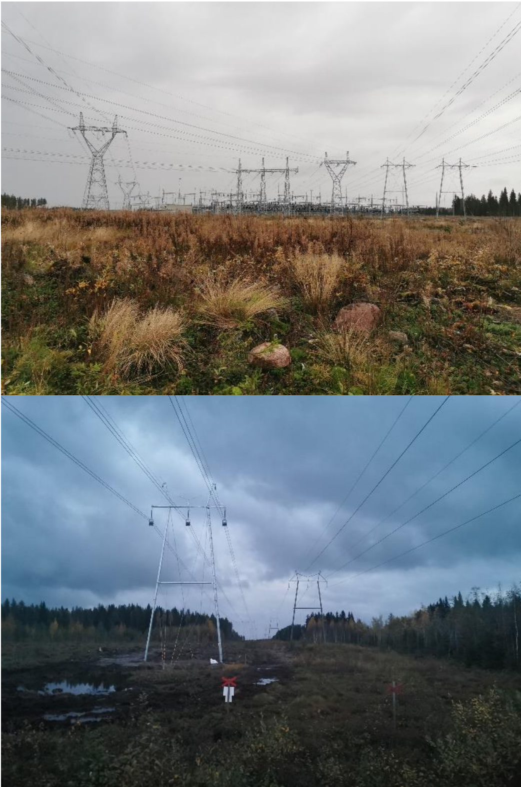
Kuva 27. Yllä kuva maiseman nykytilasta Pysäysperän sähköasemalla. Kuva on otettu aseman eteläpuolelta pohjoisen suuntaan. Alla maisemaa Elenian Pyhäjärvi-Haapajärvi voimajohdon johtokäytävästä, johon uutta Elenian Haapajärvi-Ruotanen voimajohtoa on jo rakennettu. Itämäen ja Murtomäki 2 hankkeiden voimajohtoja suunnitellaan kyseisten johtojen rinnalle. Kuvat on otettu lepakkoselvityksen tekemisen yhteydessä syyskuussa 2023.
