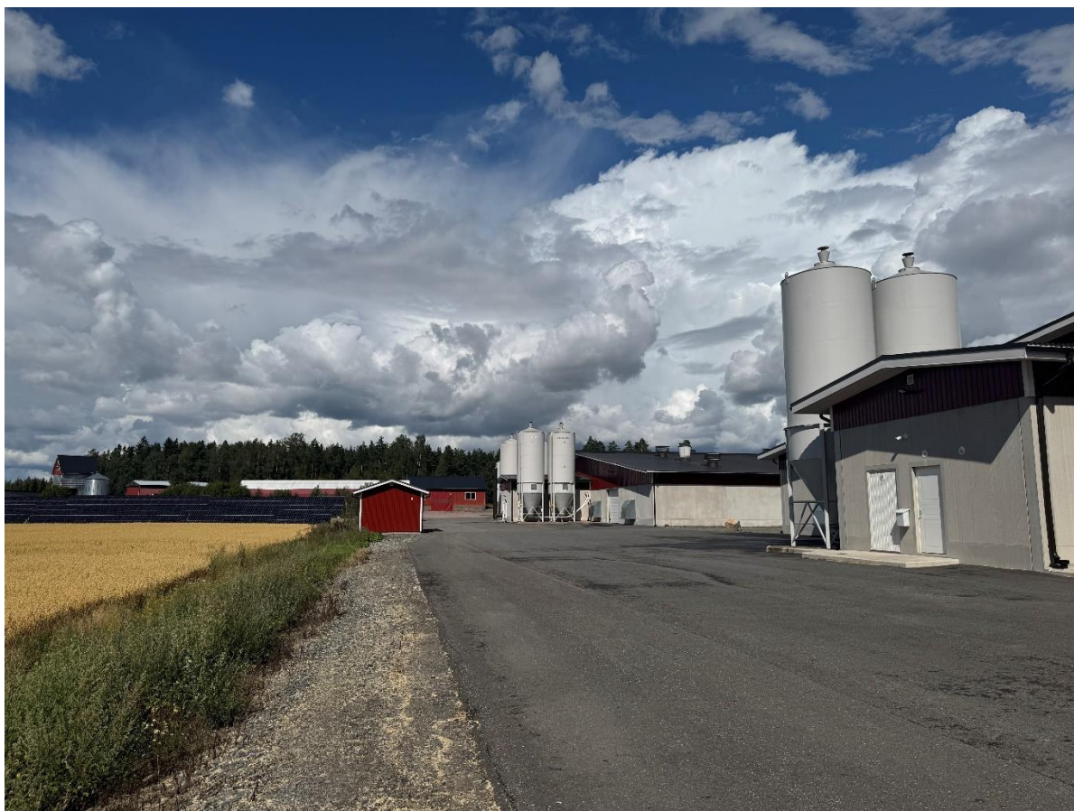
Kuva 22. Nykyinen broilerikasvattamo etelästä päin kuvattuna.
