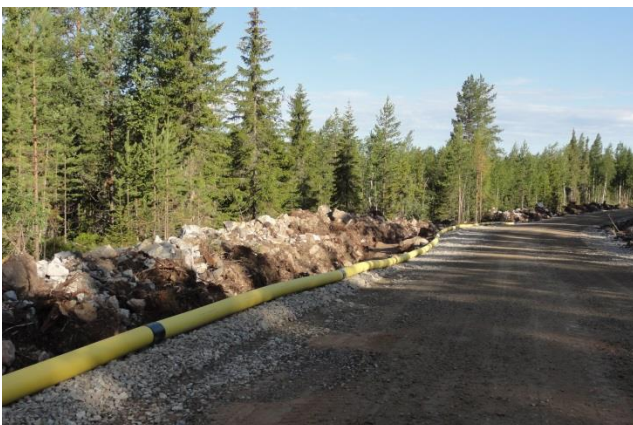
Kuva 2.17. (Vasemmalla) Esimerkki tuulivoimapuiston rakennus- ja huoltotiestä rakentamisaikana. Teitä käytetään muun muassa betonin, soran ja voimaloiden komponenttien kuljetuksiin sekä tuulivoimapuiston käyttövaiheessa huoltoajoihin. Maakaapeli sijoitetaan ojakaivantoon tien reuna-alueelle. (Oikealla) Tuulivoimalan osia kuljetetaan erikoiskuljetuksina. (Kuvat: Ville Suorsa / FCG).
