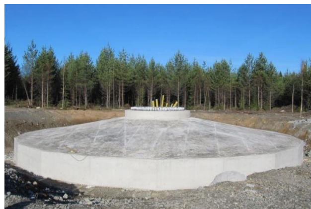
Kuvapari 2.21. Tuulivoimalan perustusten rakentamista (kuvat: Leila Väyrynen, FCG).
