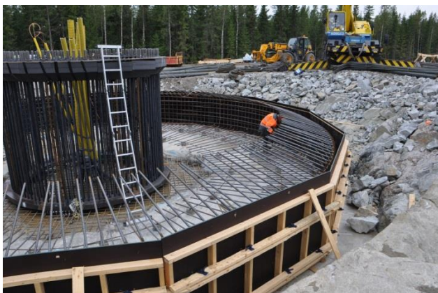
Kuvapari 2.21. Tuulivoimalan perustusten rakentamista (kuvat: Leila Väyrynen, FCG).
