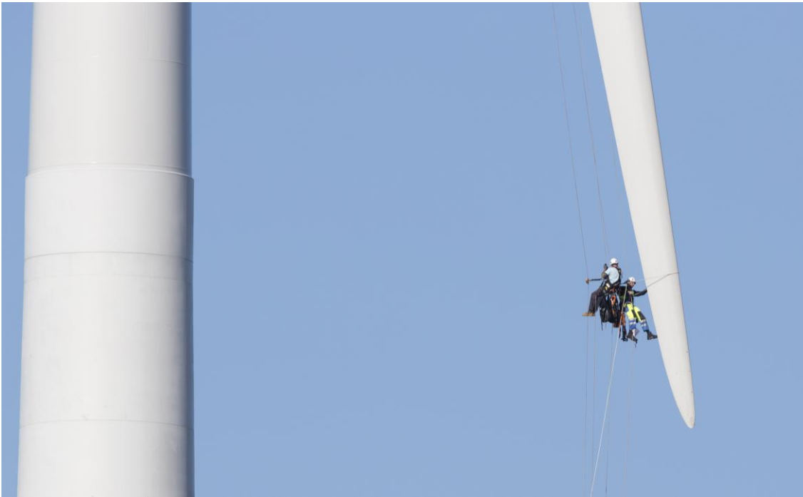
Kuva 5.15. Tuulivoimalan huoltotoimenpiteitä. (Kuva: Ville Suorsa, FCG).
