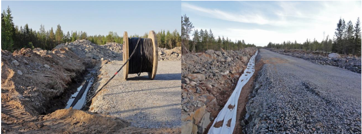
Kuvapari 5.10. Maakaapelit upotetaan huoltoteiden yhteyteen (kuvat: Ville Suorsa/FCG).
