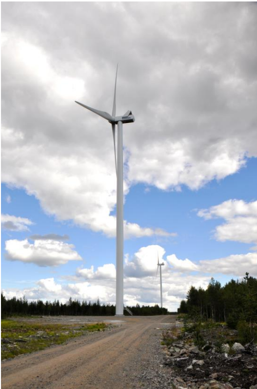
Kuva 5.1. Vasemmalla on esimerkki teräslieriötornista ja oikealla hybriditornista. (Kuvat: Leila Väyrynen, FCG)
