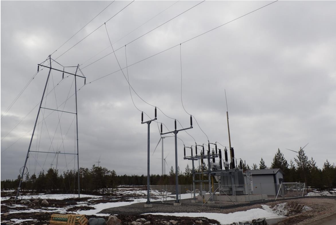
Kuva 5.8. Esimerkkikuva tuulivoimapuiston sisäisestä 20/110 kV sähköasemasta. (Kuva: Ville Suorsa / FCG).
