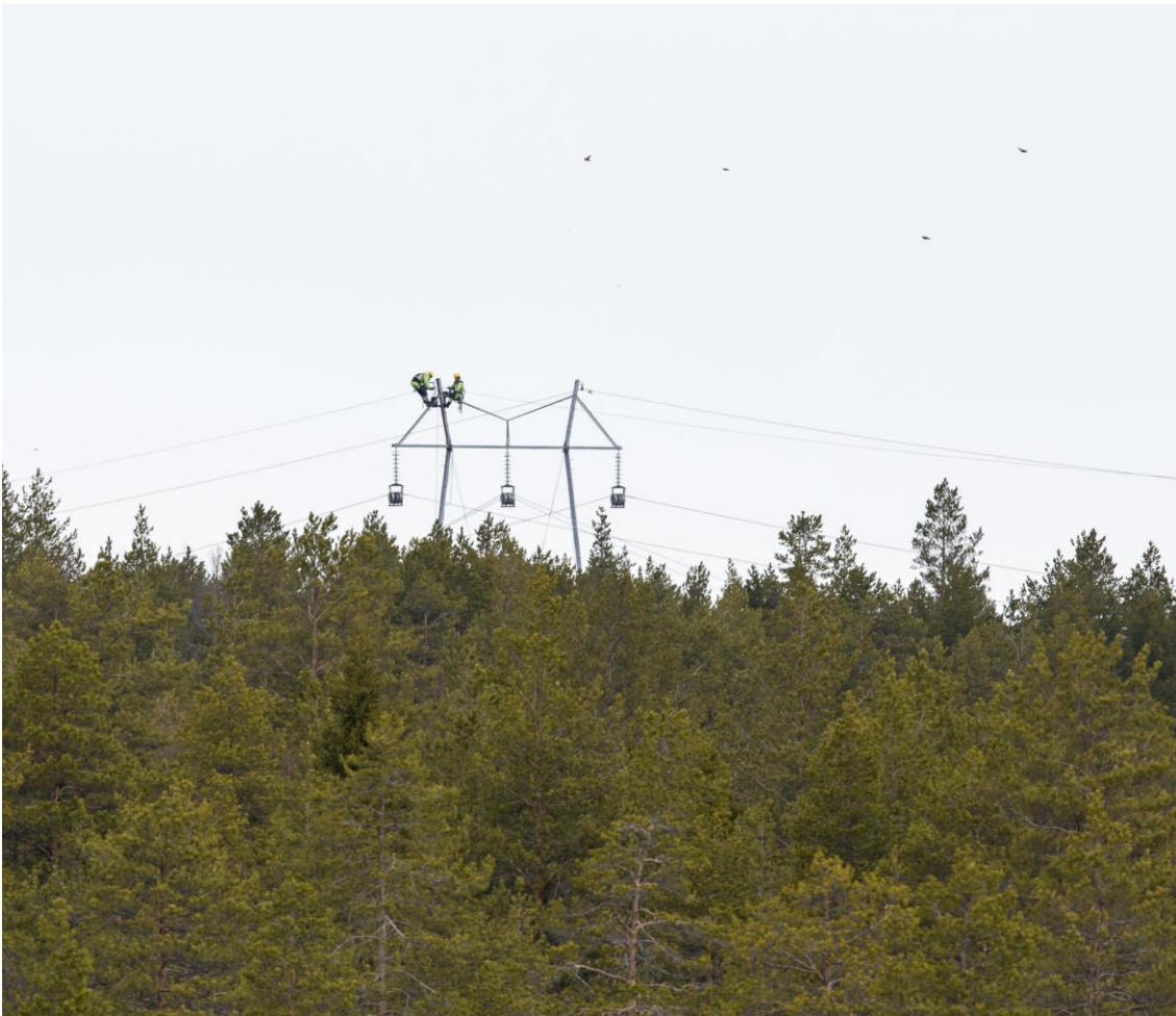
Kuva 5.13. Voimajohdon johdinten asentaminen käynnissä. (Kuva: Ville Suorsa, FCG).
