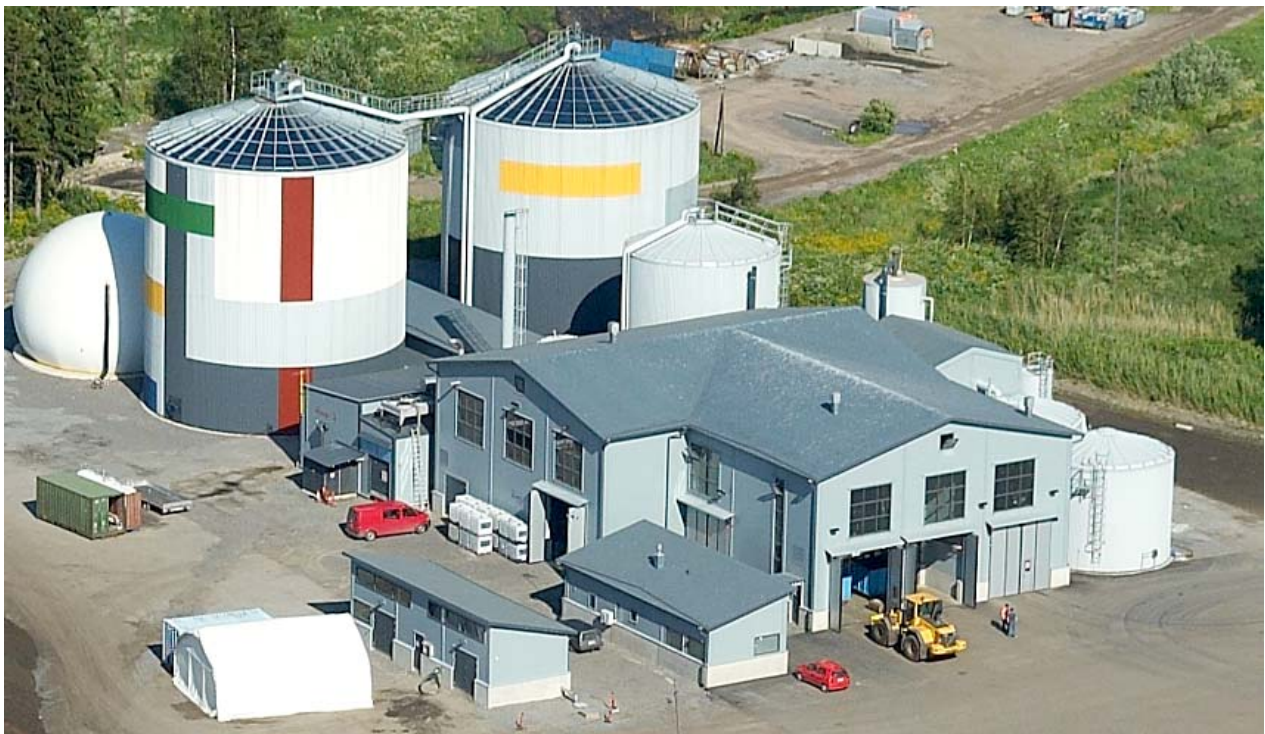
Kuva 3.4. Turun Topinojan biokaasulaitos (kuva: Biovakka Suomi Oy).
