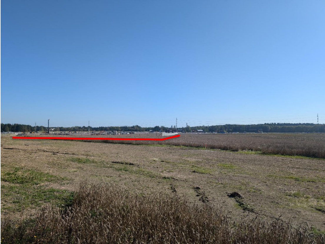
Kuva 3-4. Näkymä hankealueelle Isopatriantieltä. Kuvaussuunta on lounaaseen. Aidattu alue (vasemmalle päin, punainen viiva on aitalinja) on hankealueen pohjoisosaa ja aitaamaton alue (oikealle) hankealueen eteläosaa. Taustalla näkyy rakenteilla olevan datakeskuksen työmaalla olleet paalutuskoneet sekä voimalinjan pylväät. Valokuva: Anthesis Finland Oy, 11.9.2025.
