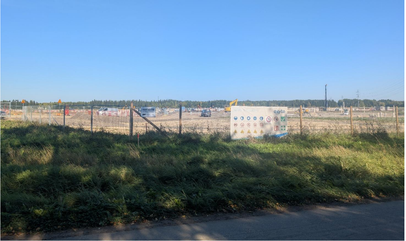
Kuva 8-5. Datakeskusalue kuvattuna Vilppulantieltä päin. Hankealueen vieressä on käynnissä TikTokille rakennettavan datakeskuksen rakentaminen (paalutuskoneet kuvan oikeassa reunassa) ja hankealueen osa toimii työmaan varastoalueena tällä hetkellä (ei näy kuvassa). Kuva on syyskuulta 2025. Helmikuussa 2026 rakenteilla on jo itse datakeskusrakennus. Kuva: Mikko Vuorela, Anthesis.
