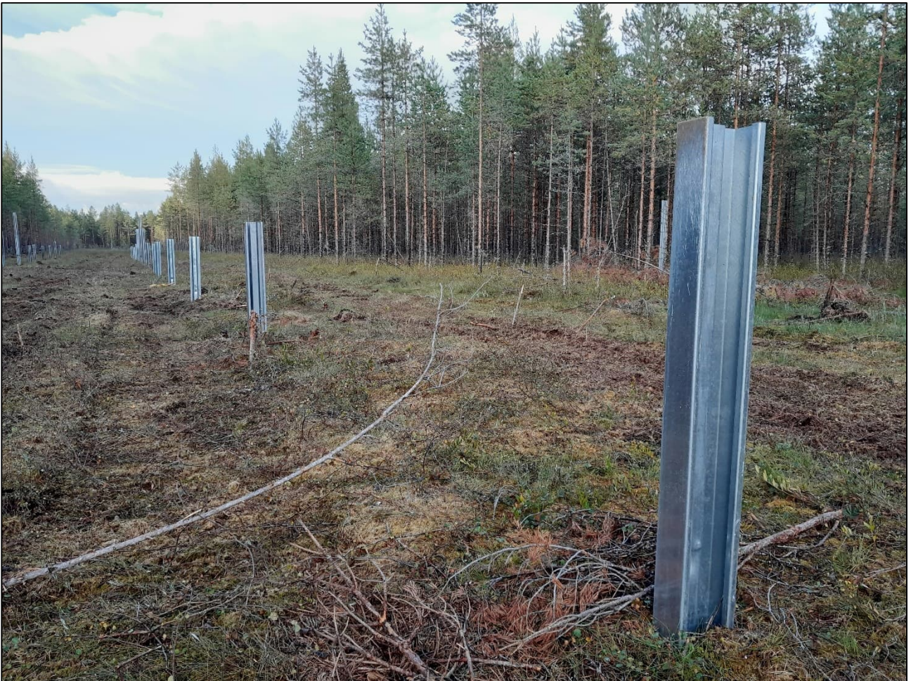
Kuva 15. Turvealueille paneelien perustukset toteutetaan pohjamaahan saakka ulottuvilla teräsprofiilipaaluilla.
