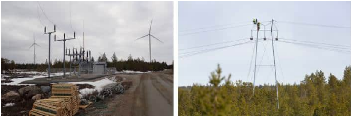
Kuva 5-17. Sähkösäntan ja voimajohdon rakentamista (FCG Rakennettu Ympäristö Oy).
