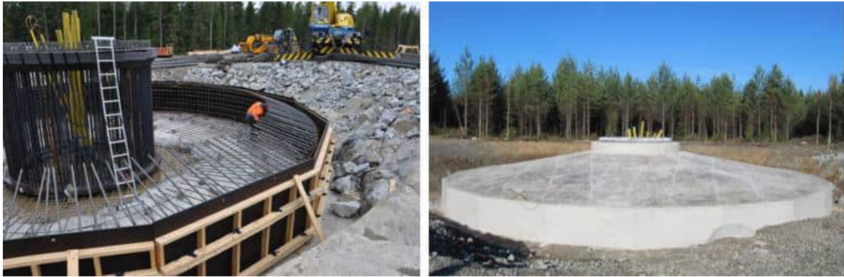
Kuva 5-13. Tuulivoimalan perustusten rakentamista (FCG Rakennettu Ympäristö Oy).
