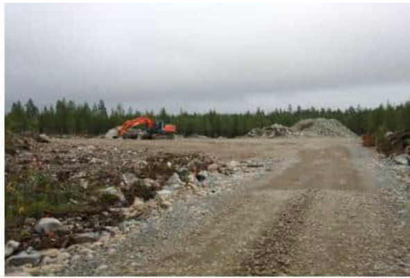
Kuva 5-11. Tuulivoimaloiden rakentaminen alkaa huoltoteiden ja pystytysalueiden rakentamisella (FCG Rakennettu Ympäristö Oy).
