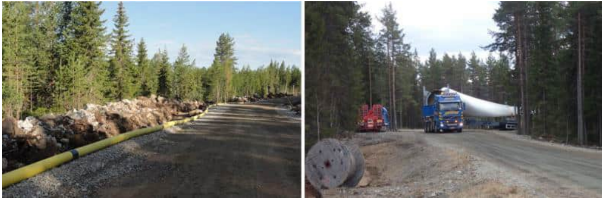
Kuva 5-6. Vasemmalla esimerkki tuulivoimahankkeen rakennus- ja huoltotiestä. Oikealla tuulivoimalan osia kuljetetaan erikoiskuljetuksina (FCG Rakennettu Ympäristö Oy).
