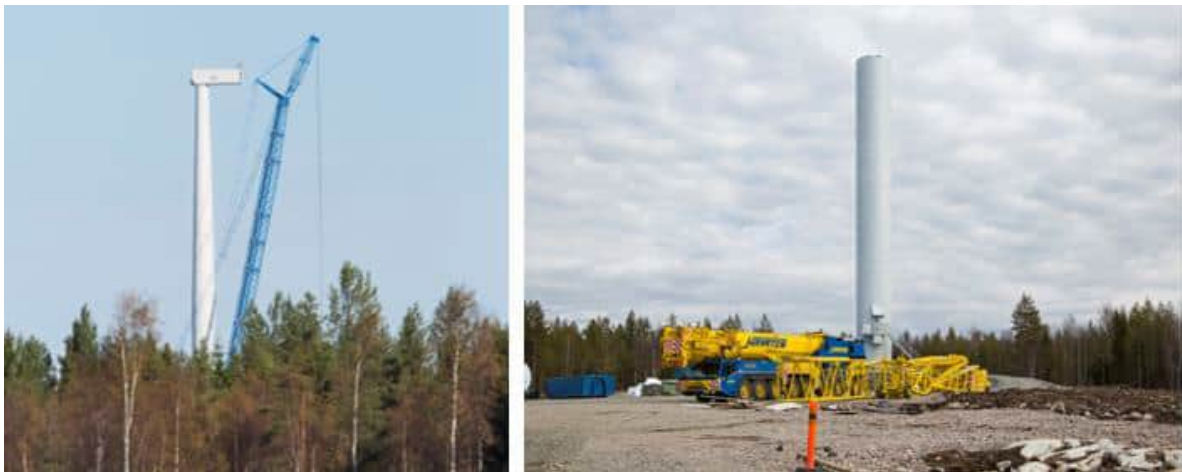
Kuva 5-14. Tuulivoimalan kokoamista (FCG Rakennettu Ympäristö Oy).
