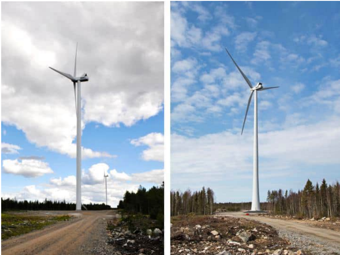
Kuva 5-2. Vasemmalla on esimerkki teräslieriötornista ja oikealla hybriditornista (FCG Rakennettu Ympäristö Oy).
