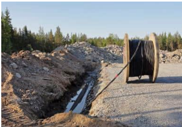
Kuva 5-12. Maakaapelit upotetaan huoltoteiden yhteyteen (FCG Rakennettu Ympäristö Oy).
