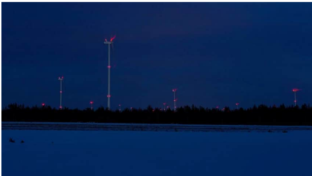
Kuva 5-4. Kiinteät punaiset lentoestevalot (FCG Rakennettu Ympäristö Oy).
