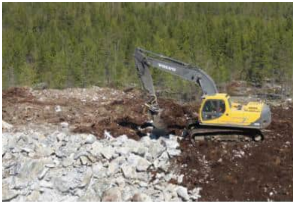
Kuva 5-11. Tuulivoimaloiden rakentaminen alkaa huoltoteiden ja pystytysalueiden rakentamisella (FCG Rakennettu Ympäristö Oy).
