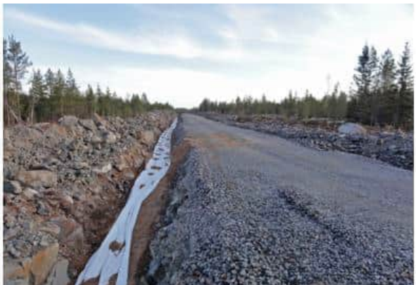
Kuva 5-12. Maakaapelit upotetaan huoltoteiden yhteyteen (FCG Rakennettu Ympäristö Oy).
