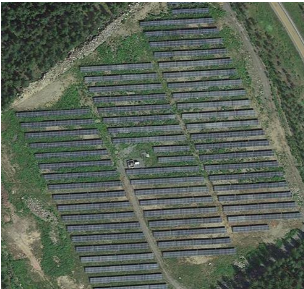
Kuva 29. Ilmakuva Lempäälän energiayhteisön aurinkovoimalasta. Kentän koko on 2,5 ha (Kuva: Google Maps, 2022).
