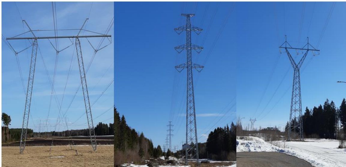
Kuva 14. Yhteispylvästyyppejä. Vasemmalla harustettu portaalipylväs, keskellä "Tannenbaum"-pylväs ja oikealla Y-pylväs. (Kuvat: S. Heinonen, 2022)
