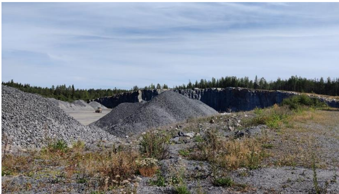
Kuva 31. Korkeakallion kalliomurskaamo (Arkkitehtitoimisto Ajak Oy, 2022).
