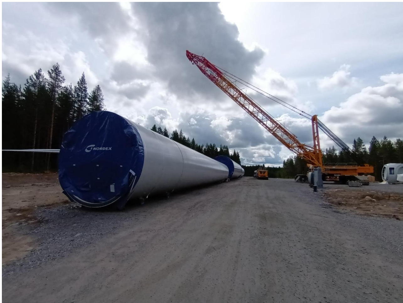
Kuva 7. Tuulivoimalan rungon osia nostoalueella odottamassa pystytystä. Kuva: Niina Pirttiniemi.
