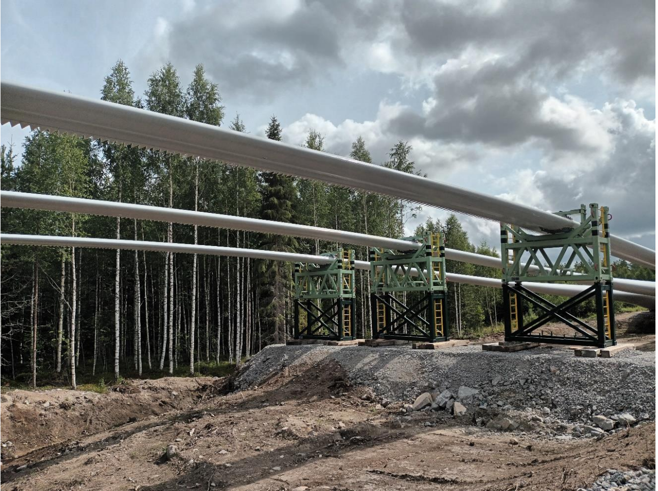
Kuva 9. Tuulivoimaloiden lapoja varastoituina odottamassa asentamista. Kuva: Niina Pirttiniemi.
