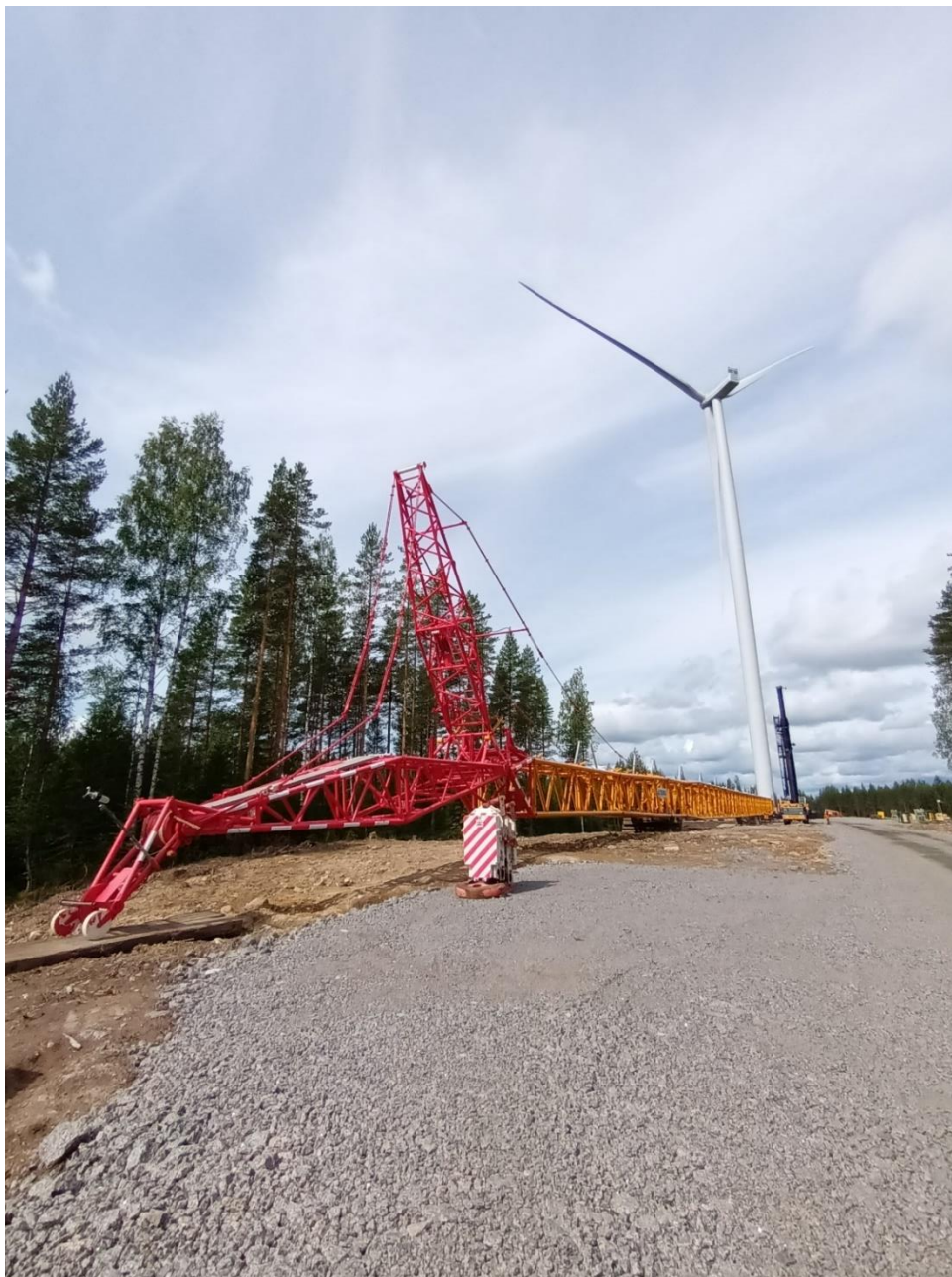
Kuva 8. Tuulivoimalan pystyttäminen. Kuva: Niina Pirttiniemi.
