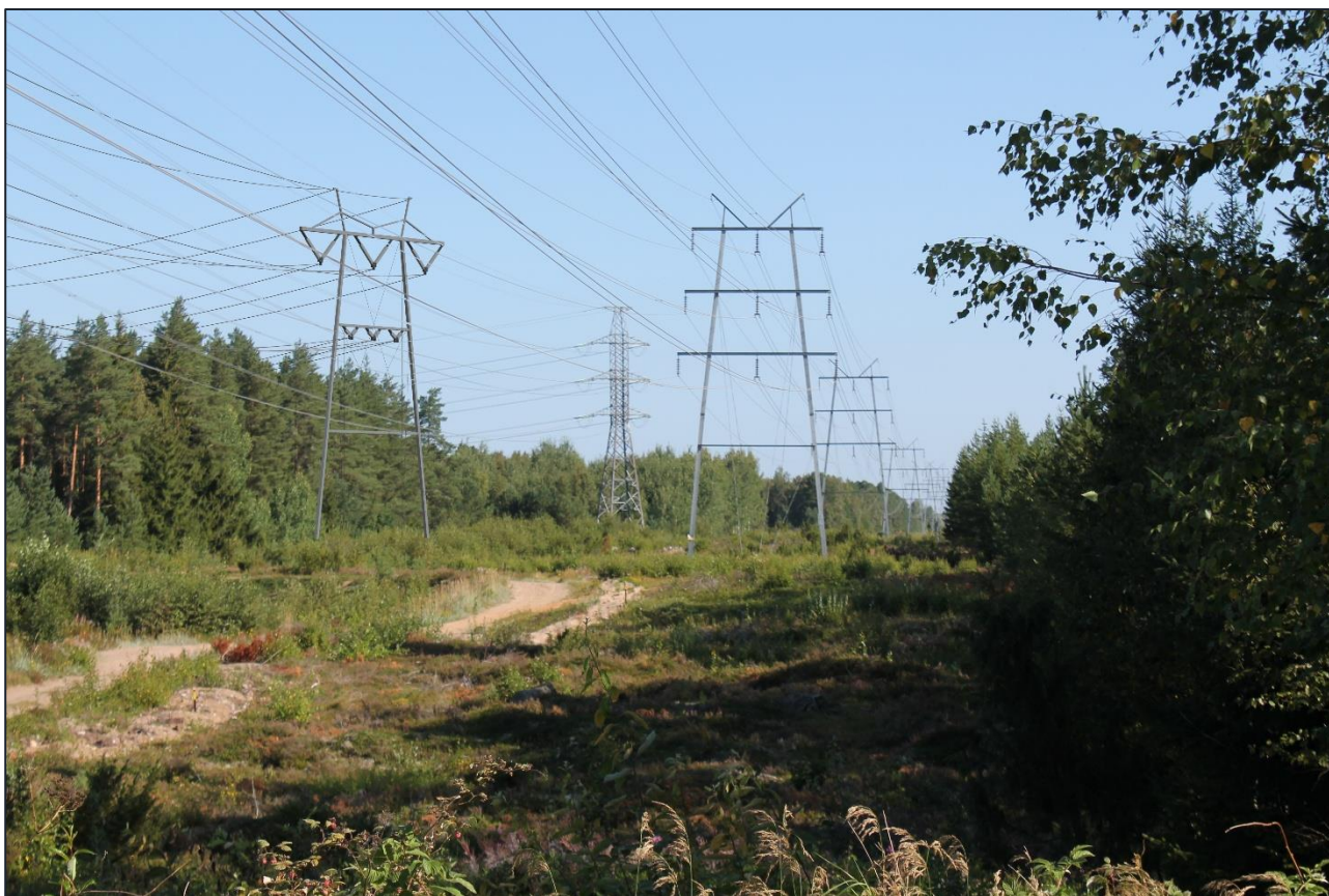
Kuva 16-4. Suunniteltu voimajohto sijoittuu pääosin olemassa olevalle johtoaukealle. Havainnekuva voimajohdon reittivaihtoehdon VJ1a varrelta Korp mossenin lounaispuolelta. Johtoaukeaa levennetään kuvan vasemmasta reunasta. (Havainnekuva: kuvauspiste 3, Envineer Oy.)
