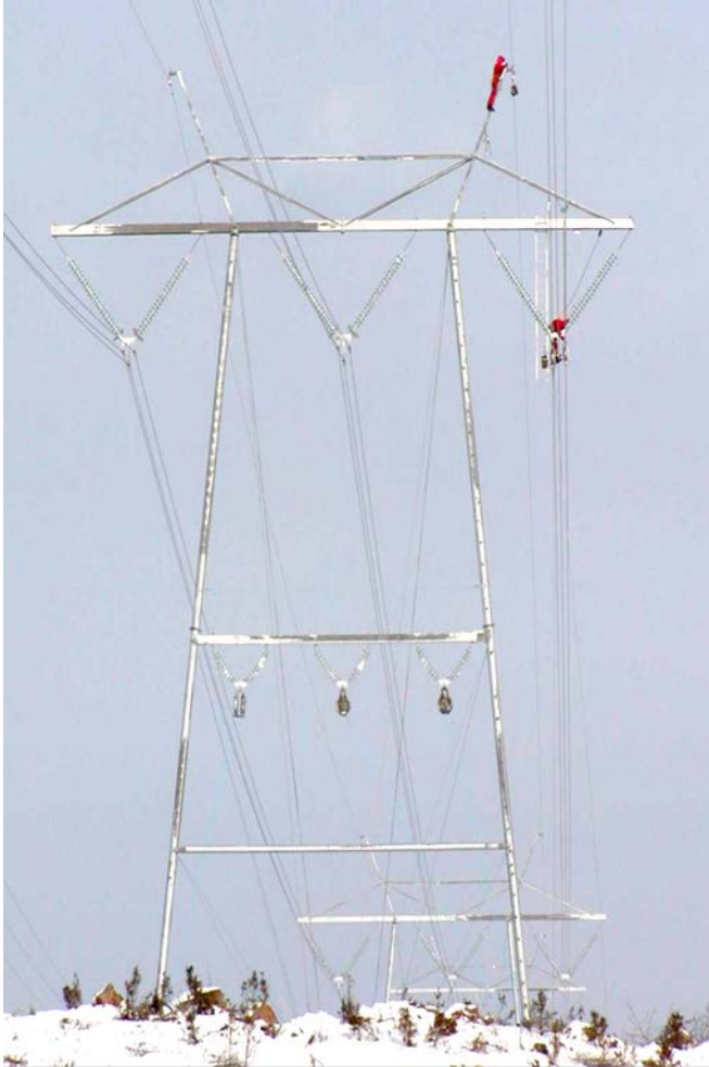
Kuva 10. Hankkeen perusratkaisuna käytettävä harustettu 400+110 kilovoltin portaalipylväs.
