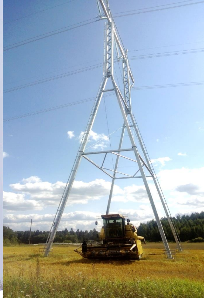
Kuva 10. Hankkeen perusratkaisuna käytettävä harustettu 400+110 kilovoltin portaalipylväs.
