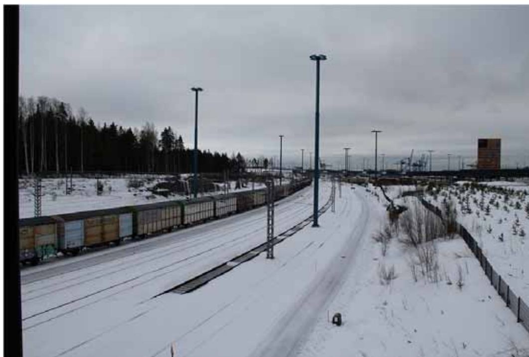
Kuva 5-6. Yleiskuva suunnitellun junanpurkupaikan alueelta (kuva: Helsingin Energia).
