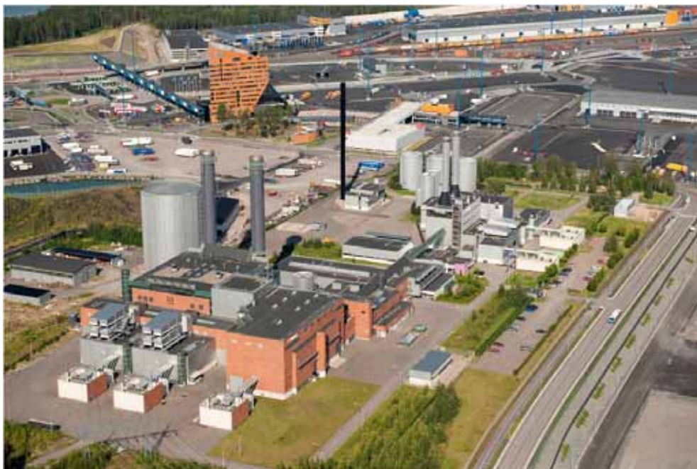
Kuva 2-1. Vuosaaren A- ja B- voimalaitokset (kuva: Helsingin Energia).
