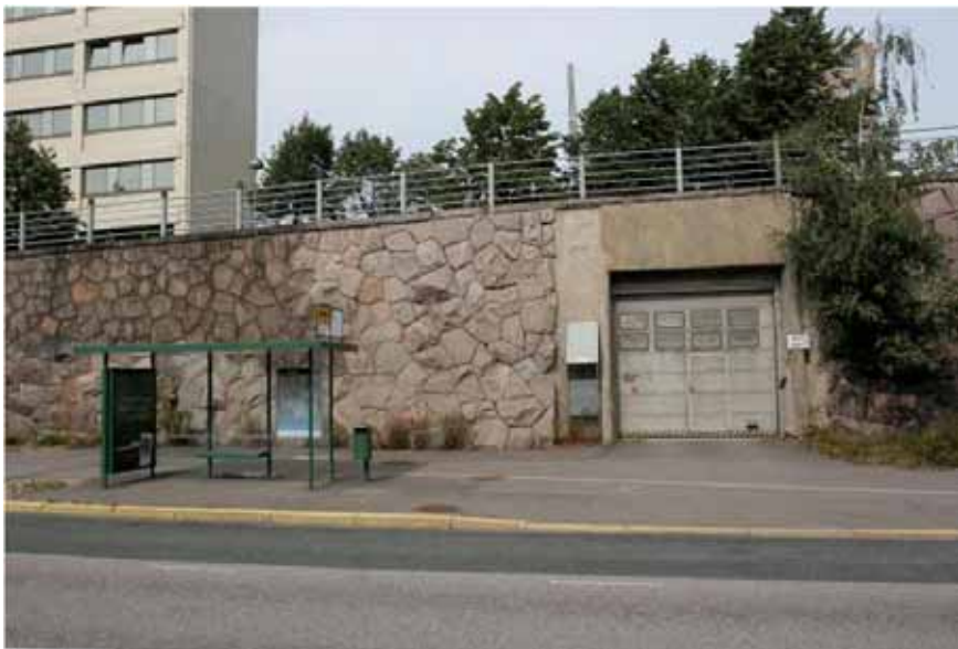
Kuva 11-6. Esimerkkikuva jo toteutetusta ajotunnelista (kuva: Helsingin Energia).
