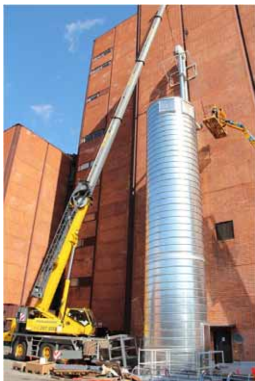
Kuva 11-8. Esimerkkikuva pellettisäiliön pystytyksestä (kuva: Helsingin Energia)
