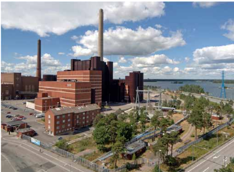
Kuva 2-3. Salmisaaren A- ja B- voimalaitokset (kuva: Helsingin Energia).
