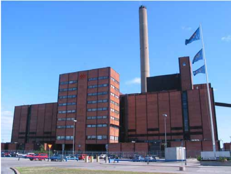
Kuva 2-2. Hanasaaren B- voimalaitos (kuva: Helsingin Energia).
