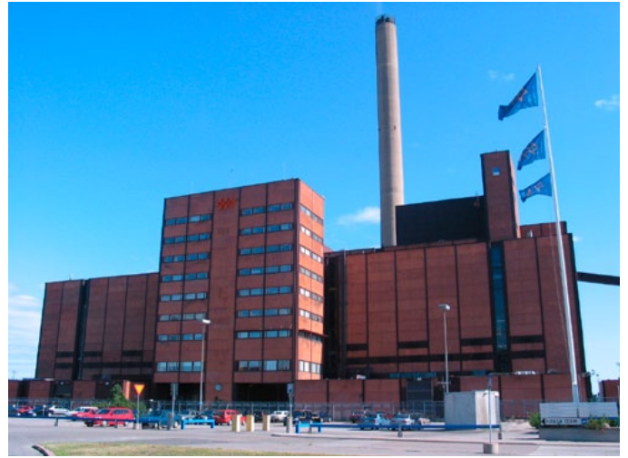
Kuva 2-2. Hanasaaren B-voimalaitos (kuva: Helsingin Energia).
