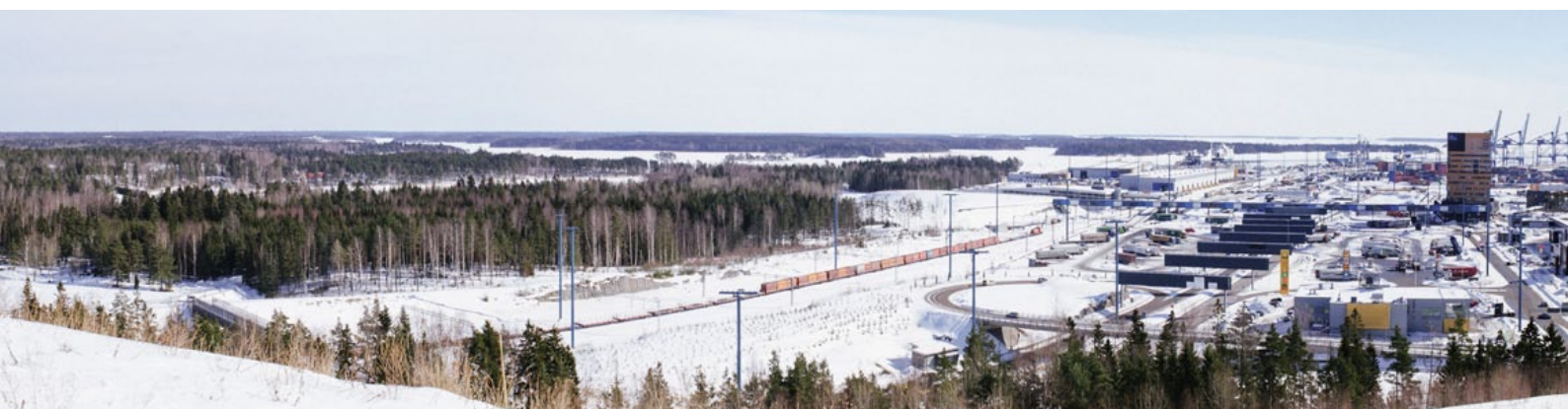
Kuva 21-36. Kuva hanke-alueen nykytilasta Vuosaaren Huipulta kuvattuna.
