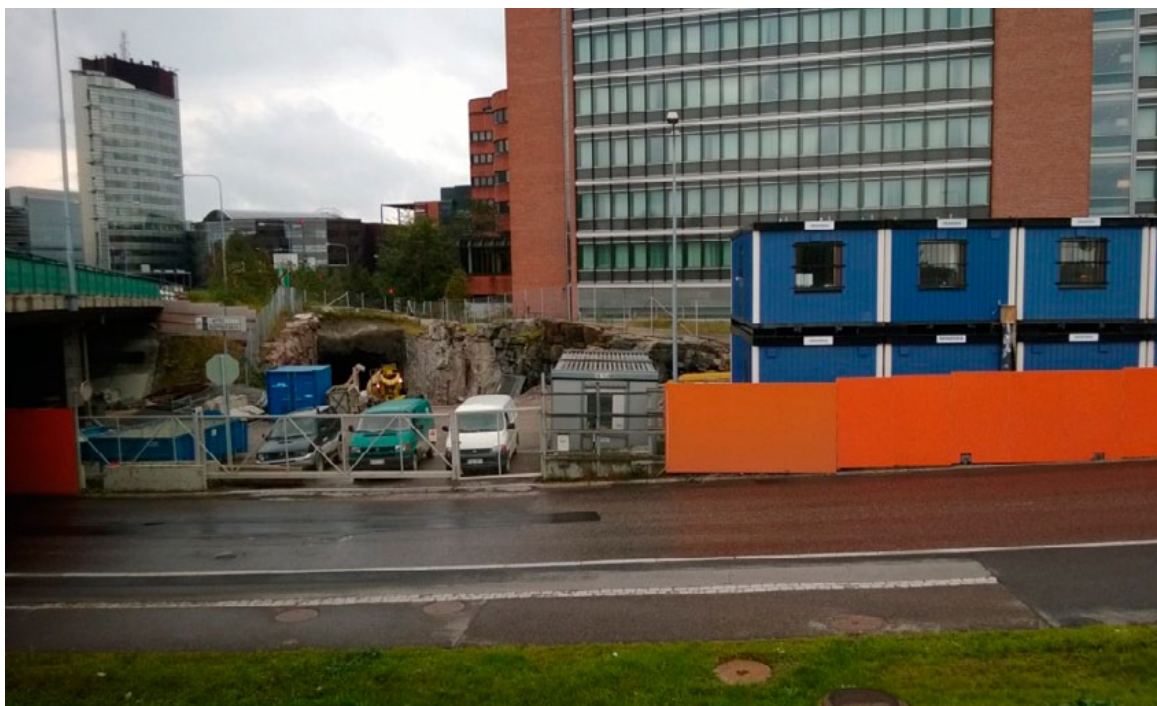
Kuva 5-13. Louhintatyö meneillään (kuva: YIT).
