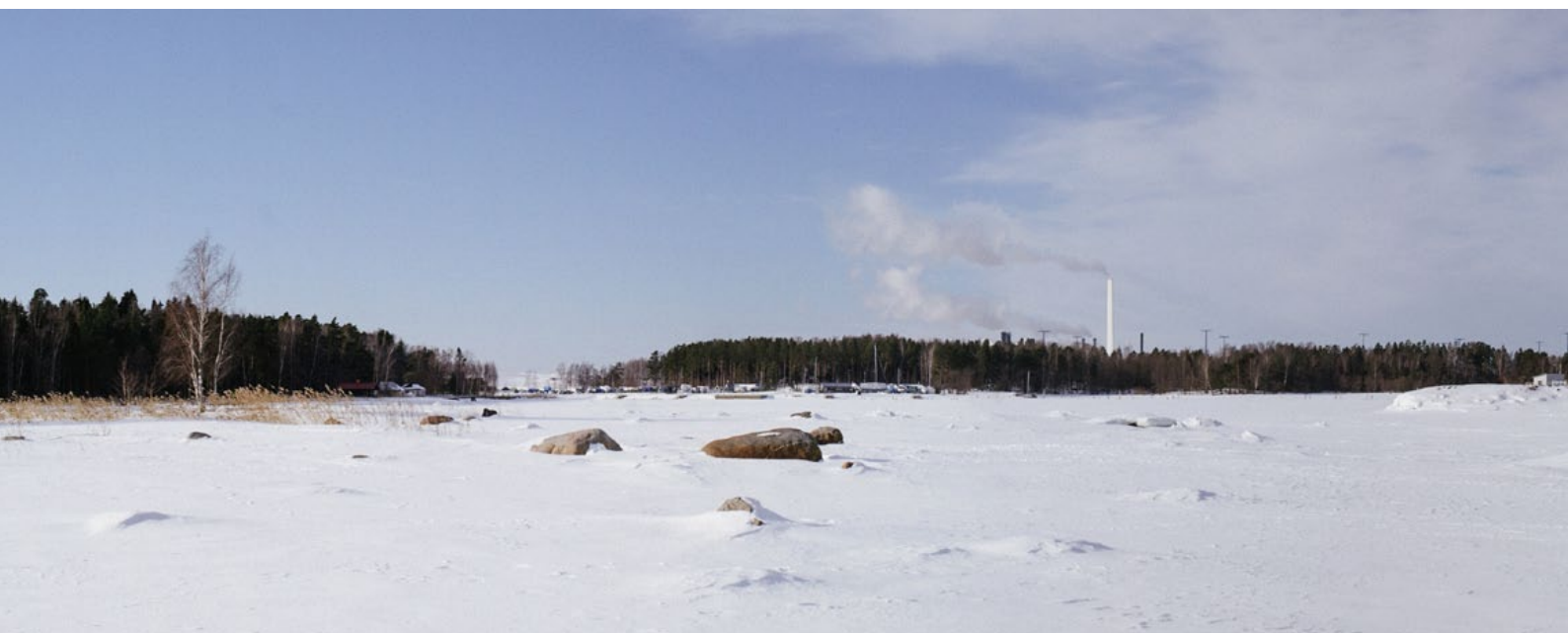
Kuva 21-47. Kuvasovite VE1 suunnitellusta rakentamisesta nähtynä Särkkälähdelta, sataman eteläpuolelta. Vain Vuosaaren C-voimalaitoksen piippu nousee näkyviin metsänrajan yläpuolelle. Kuvasovite: Arkkitehtitoimisto Virkkunen & Co.
