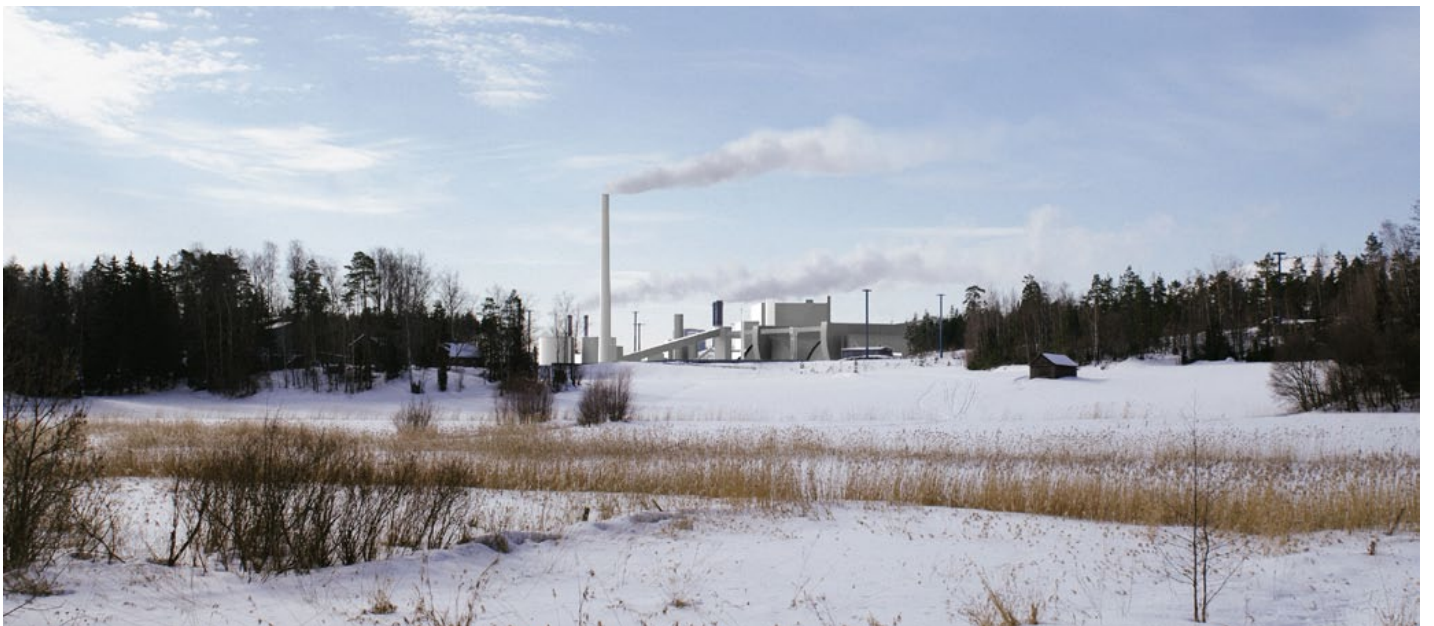
Kuva 21-43. Kuvasovite hankevaihtoehdon VE1 mukaisesta rakentamisesta nähtynä Porvarinlahden pohjoispuolelta. Kuvasovite: Arkkitehtitoimisto Virkkunen & Co.
