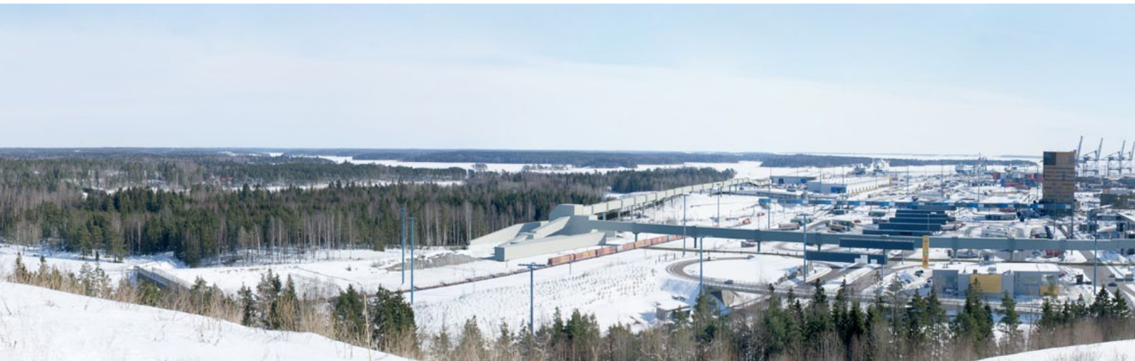
Kuva 21-38. Kuvasovite suunnitelmavaihtoehdon A2 mukaisesta rakentamisesta nähtynä Vuosaaren Huipulta. Suunnitelmassa A2 kivihiilen käyttövarasto sijoittuu kuvan oikeaan laitaan. Suunnitelmassa A2 ei ole ajoyhteyttä kuvan vasemmassa reunassa näkyvälle junien purkupaikalle. Kuvasovite: Arkkitehtitoimisto Virkkunen & Co.
