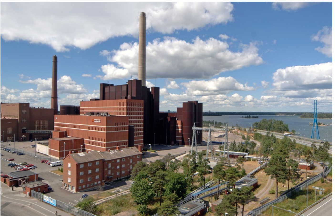
Kuva 2-3. Salmisaaren A- ja B-voimalaitokset (kuva: Helsingin Energia).
