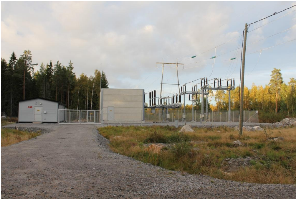
Figur 7. Exempelbild av vindkraftsprojektets 20/110 kV elstation och grenanslutning. © Veli-Pekka Alkula. Den kommande anslutningen kommer inte att vara exakt likadan som i exemplet på fotot.
