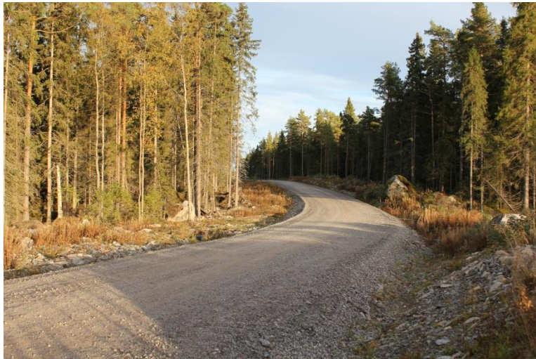
Figur 16. En serviceväg till ett vindkraftverk – Öjen, Vasa (Ramboll Finland Oy).
