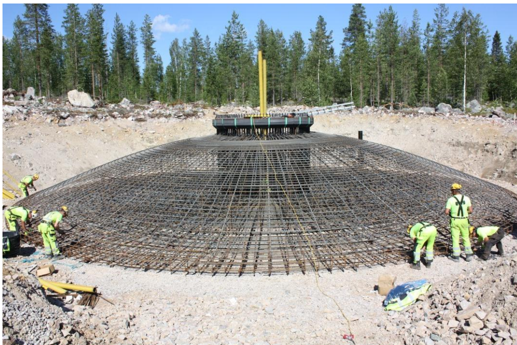
Figur 13. Armerat gravitationsfundament av stålbetong före betonggjutningen, Tervola (Ramboll Finland Oy 2013).
