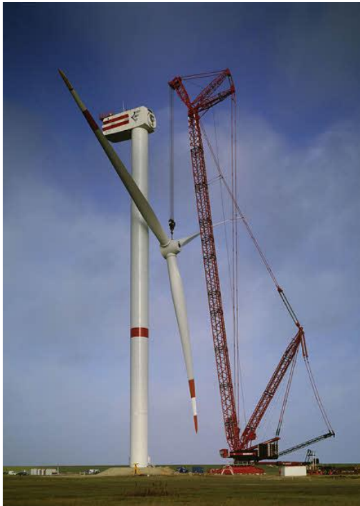
Figur 18. Resning av ett vindkraftverk med en bandgående lyftkran (Liebherr).
