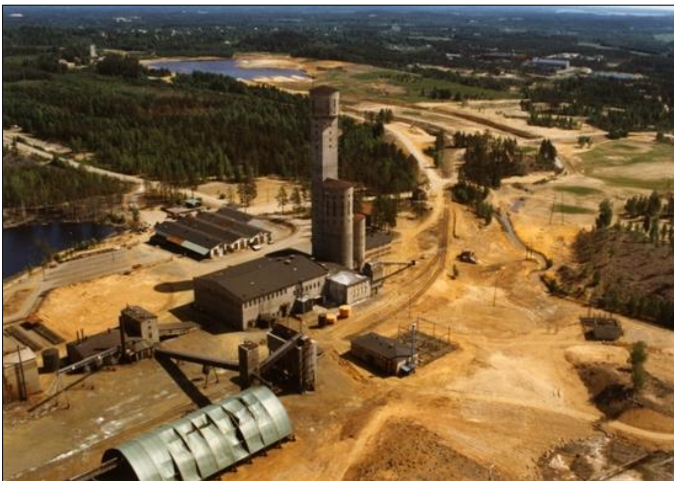
Kuva 158. Keretin kaivostorni sekä alueelta purettuja rakennuksia vuonna 1990. (Museovirasto, 2022) Nykyisin alueella on jäljellä enää kaivostorni ja siilot.
