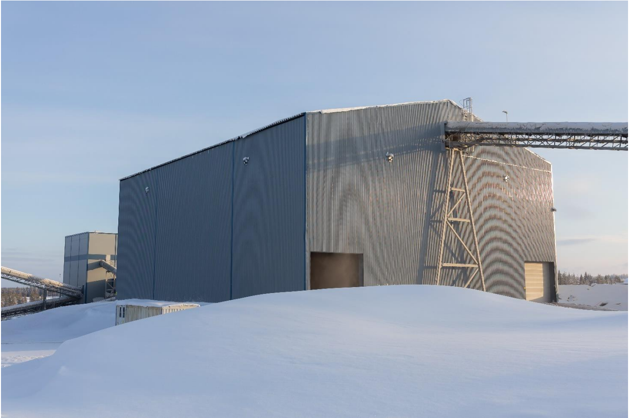
Kuva 24. Esimerkki katetusta murskatun malmin välivarastosta (Sotkamon hopeakaivos, Sotkamo Silver Oy)
