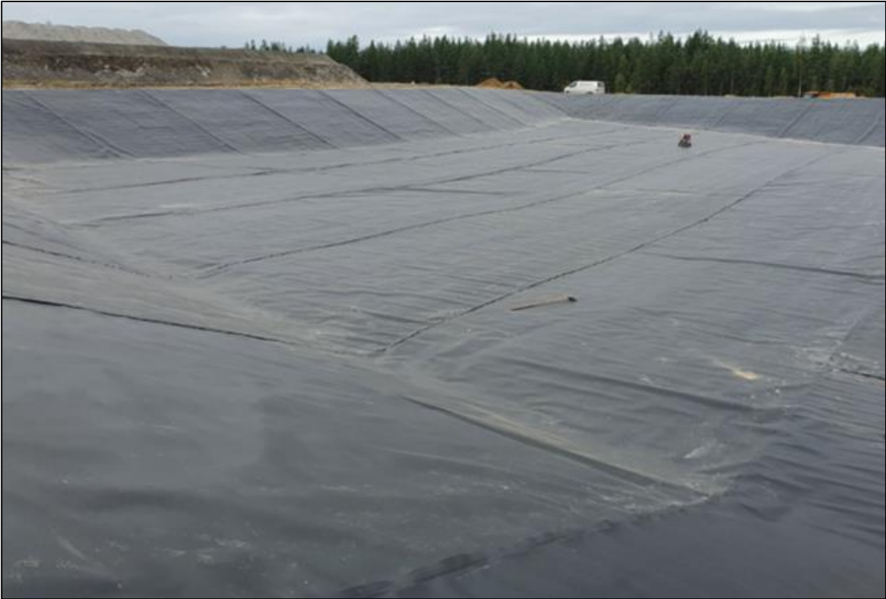
Kuva 29. Esimerkki rakenteilla olevasta vesialtaasta. (Kuva: Envineer Oy)
