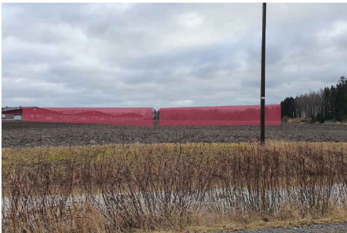
Kuva 8.10 Näkymää uusille halleille kuvanottopaikasta 4. Kuvassa näkyy vaihtoehtojen VE1 ja VE2 hallien päädyt. (kuva: hankevastaava)
