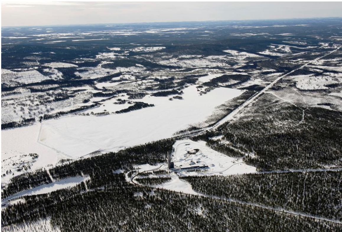
Bild 6-9. Flygbild över Rautuvaara. Bilden har tagits i riktning söderut. I bildens förgrund syns det gamla anrikningsverket och bakom detta det gamla sandmagasinet.
